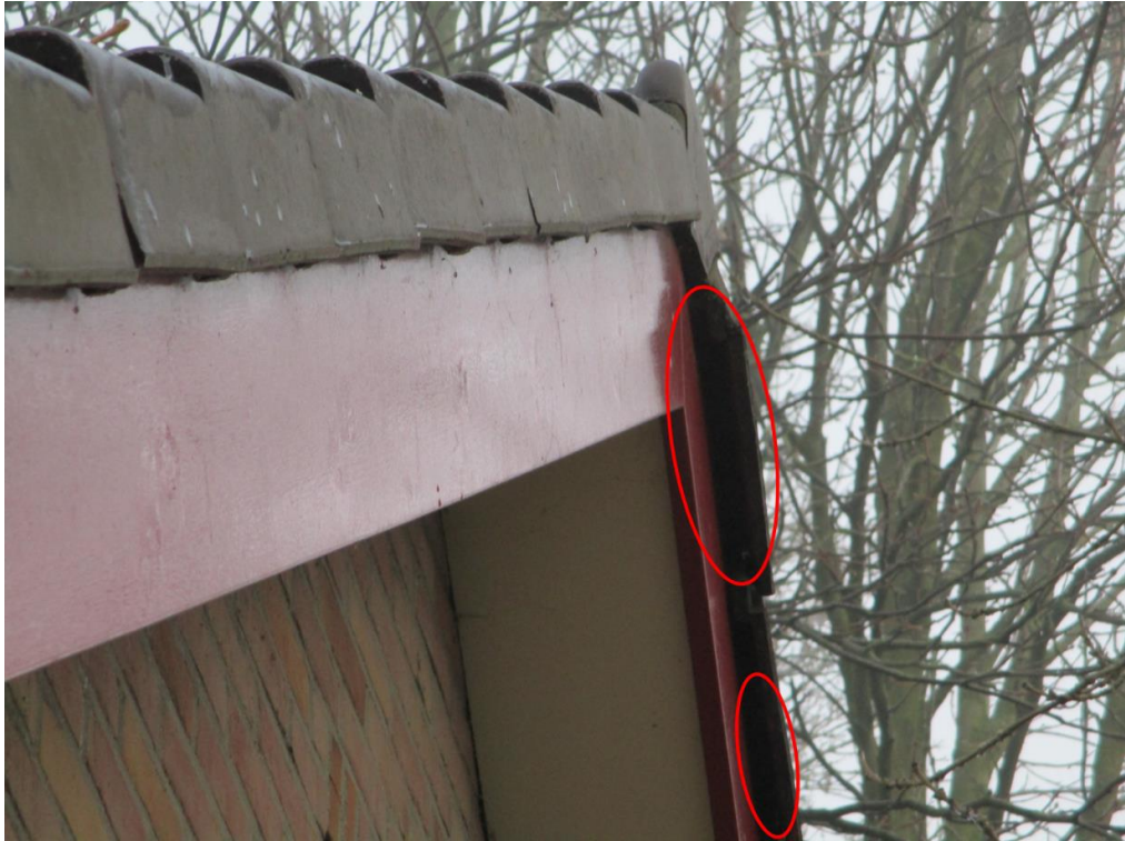
Figuur 4 Kierende kantpannen waardoor vleermuizen de ruimte onder de dakpannen kunnen betreden.
