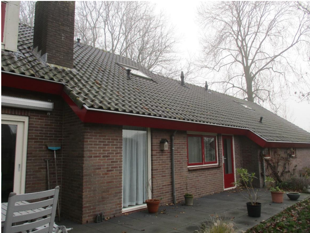
Figuur 1 De planlocatie is gelegen aan de Oudendijk 70 te Woudrichem en bestaat uit een gemetselde, spouwmuur met een zadeldak met dakpannen.
