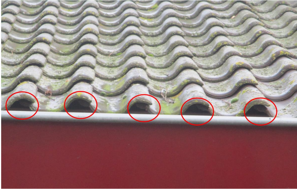
Figuur 6 De ruimte onder de dakpannen is vrij toegankelijk vanuit de dakgoot.
