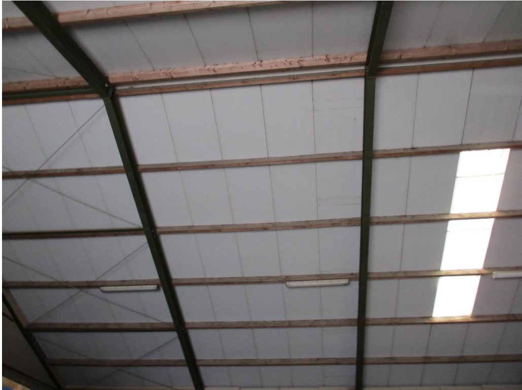
Figuur 3 Het dak is aan de binnenzijde geïsoleerd.
