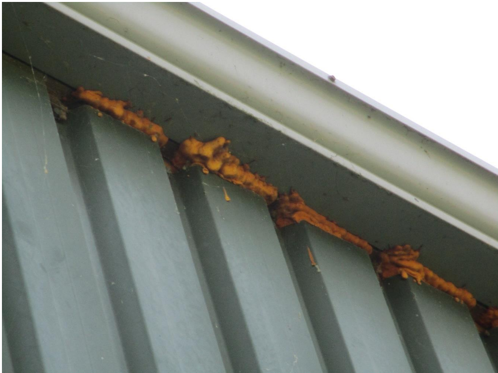
Figuur 2 In de damwandplaten is isolatiemateriaal aangebracht.
