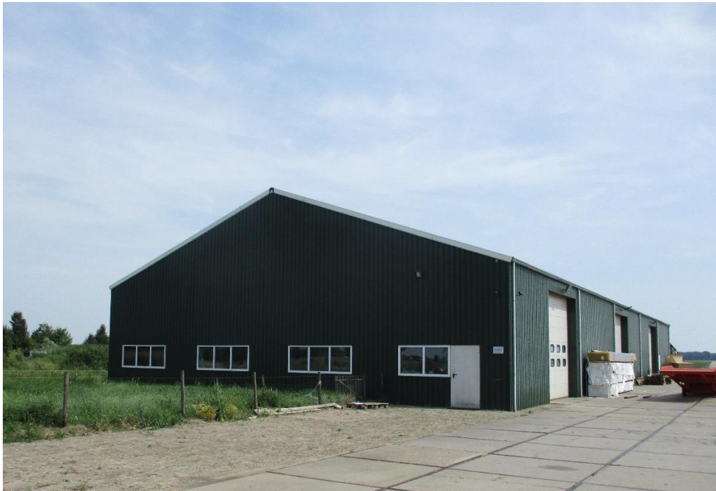
Figuur 1 De planlocatie is gelegen aan de Veldstraat 71b te Wijk en Aalburg en bestaat uit een agrarische loods opgetrokken uit damwand muren en zadeldak met geïsoleerde damwandplaten.
