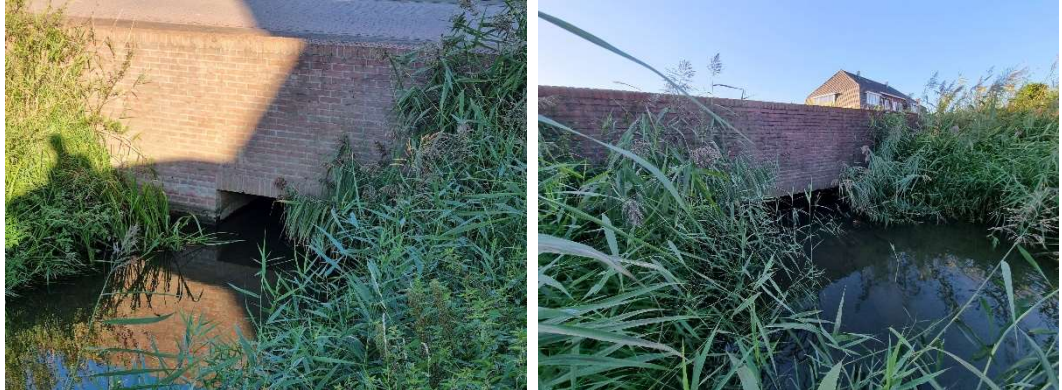
Figuur 7: Foto's duiker kruising A-watergang met weg (locatie 3)
