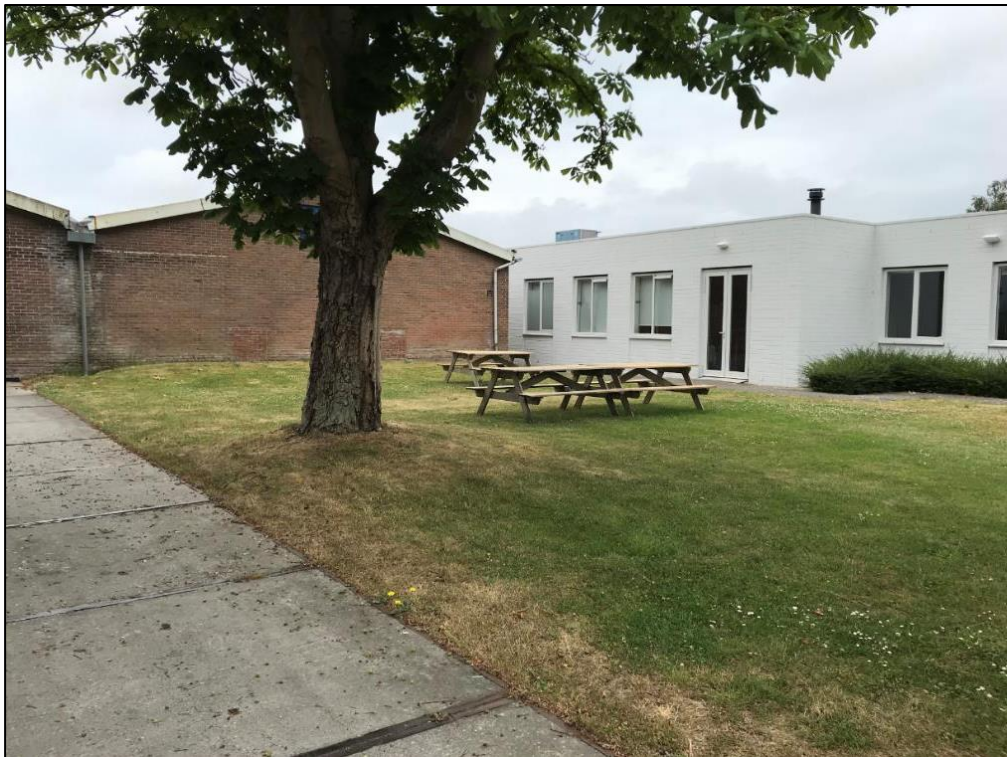
Figuur 7: Foto plangebied in zuidwestelijke richting. (juni 2020).
