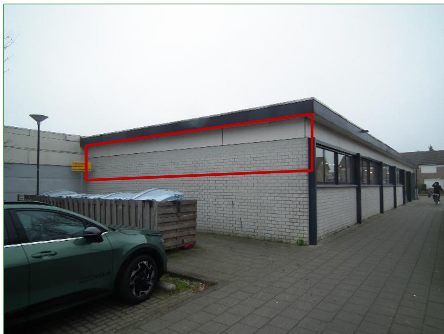
Foto's van gebouwdelen met potentie voor vleermuizen (zie rode omlijning). Boven: muur aan noordzijde met open stootvoegen en dakrand met kieren. Onder: muur aan zuidzijde met open stootvoegen en dakrand met kieren.
