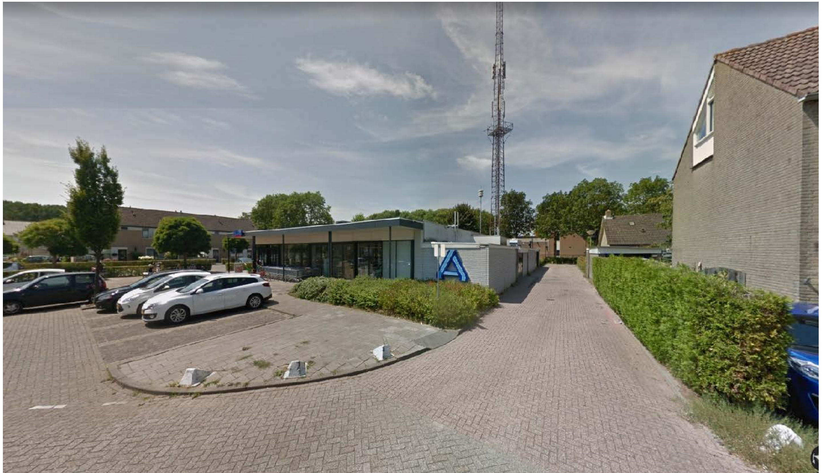
Het pand van de Aldi staat aan de rand van de wijk. Hierachter, aan de Raadhuislaan, is een sporthal gesitueerd en de brandweerkazerne. Het gebouw is éénlaags, opgetrokken uit witgrijze steen en ligt vrij van de omliggende bebouwing. Achter de winkel staat een mast, ernaast aan de bevoorradingstraat staat een trafohuisje.
