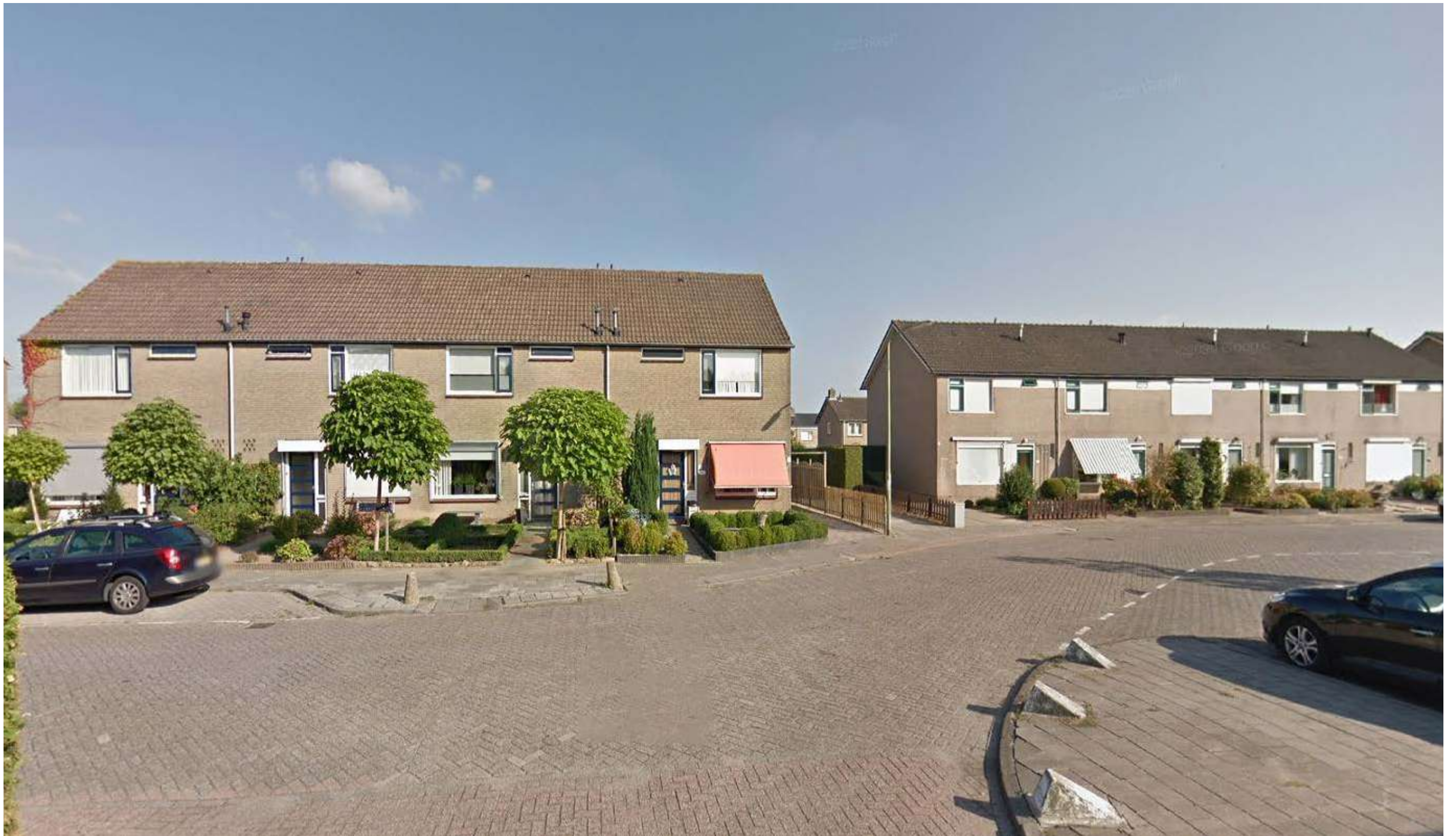
De gevels van de rijenhuizen in het midden van de straat ademen de sfeer van de woningen aan de Postelstraat en het Bentlaken, ook de bajonet in het wegverloop lijkt op de naastgelegen straten. De noordelijk ( en ook zuidelijk) gelegen woningen zijn duidelijk nieuwer en ook de woningen aan de Raadhuislaan-zijde van de Floreffestraat zijn van deze latere periode.
