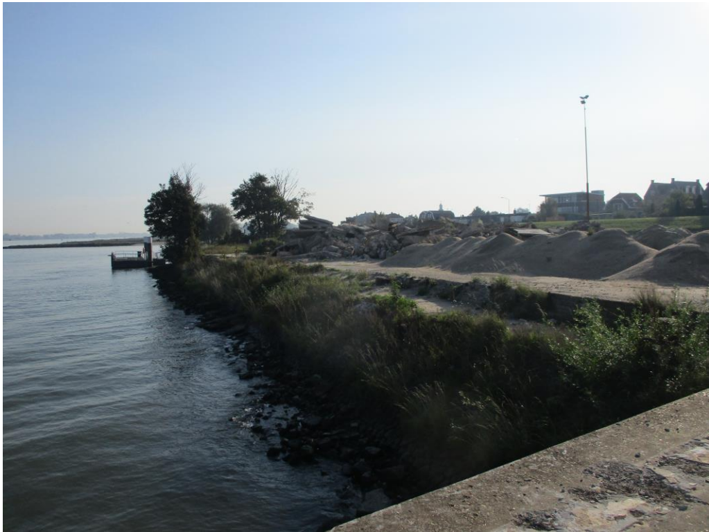
Figuur 1 De planlocatie is gelegen aan de Sasdijk 71a te Werkendam en bestaat uit een bedrijventerrein met zanddepot, puinhopen en een kade met grote keien en ruigtebegroeiing.
