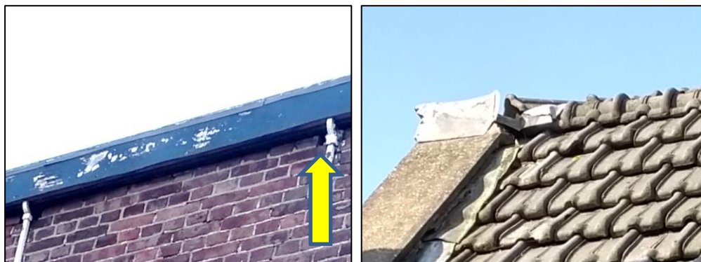
Kieren die geschikt zijn voor gierzwaluw of vleermuizen: een opening bij het muurrijzer (aangeduid met gele pijl) en bij de dakrand van het vervallen huis (linkerafbeelding) en openingen bij het lood en bij scheve dakpannen van het huis Hoogstraat 4 (rechteraafbeelding).
