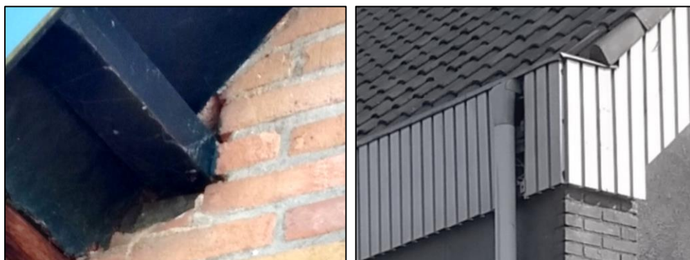
Openingen die geschikt zijn voor huismussen: een kier boven de dakbalk bij een gebouw aan de westzijde van het plangebied (links) en een opening bij de regenpijp bij een gebouw aan de zuidzijde van het plangebied (rechts).
