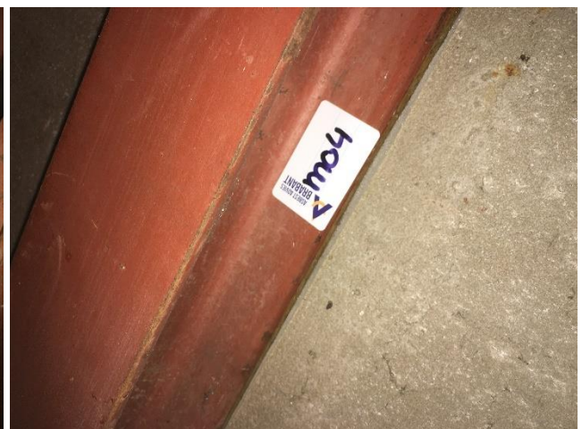
Foto 8 | Foto voor bron afdichting tussen staalconstructie en betonelementen
