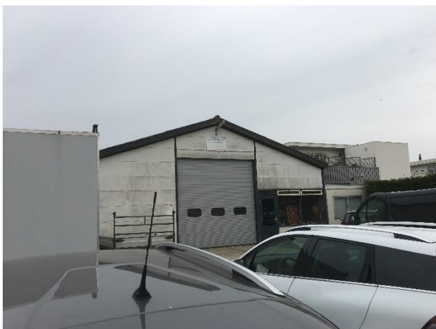
Foto 1 | Foto voor bron Golfplaat dak loods 1
