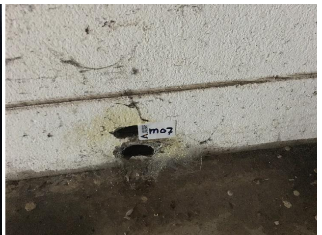
Foto 14 | Foto voor bron Gevelementen
