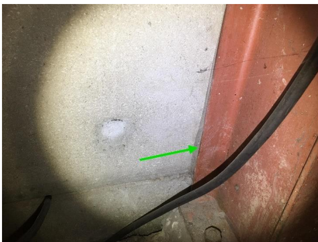
Foto 7 | Foto voor bron afdichting tussen staalconstructie en betonelementen
