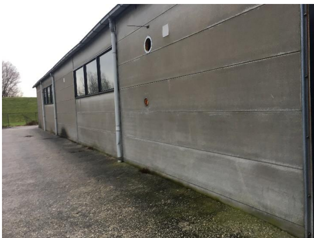
Foto 13 | Foto voor bron Gevelementen
