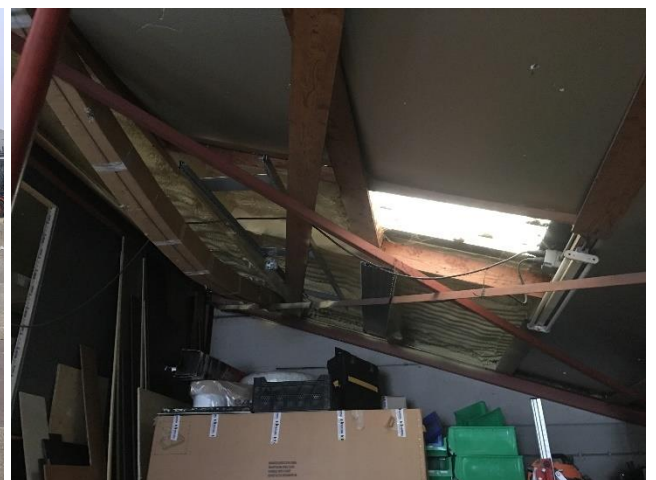
Foto 4 | Foto voor bron Golfplaat dak loods 2
