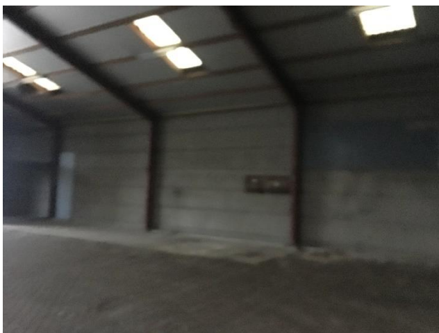
Foto 11 | Foto voor bron Gevelementen
