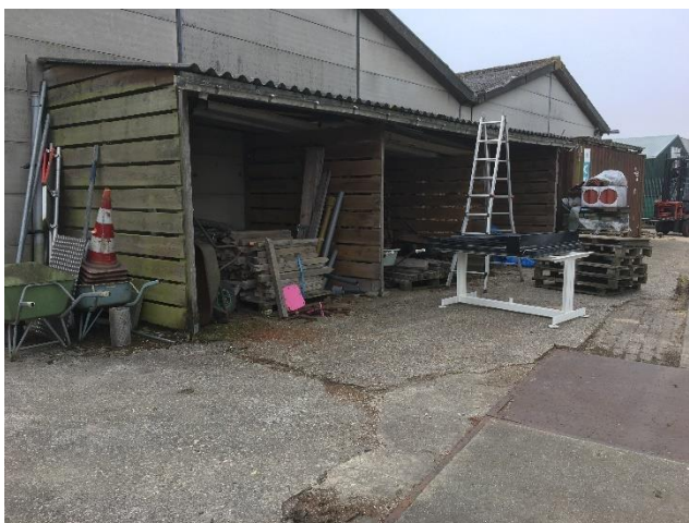
Foto 3 | Foto voor bron Golfplaat dak loods 2
