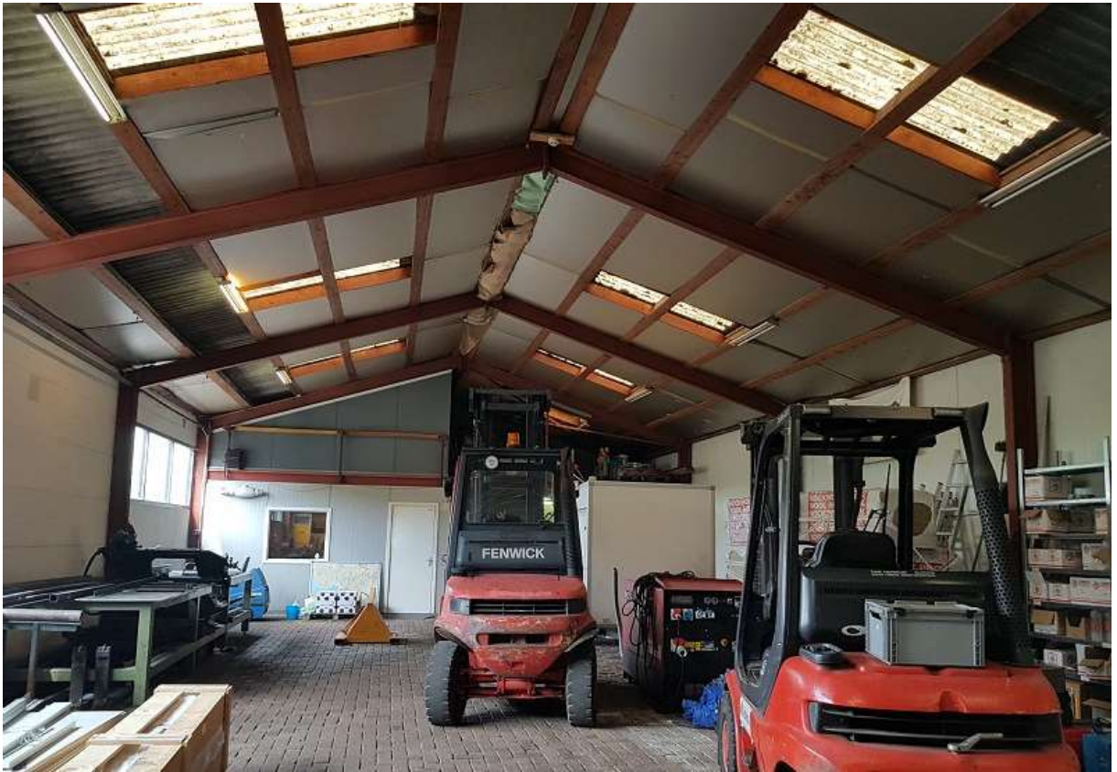
Binnenzijde bedrijfsbebouwing. Fotografie: B. Verhoeven | Ecoresult B.V.
