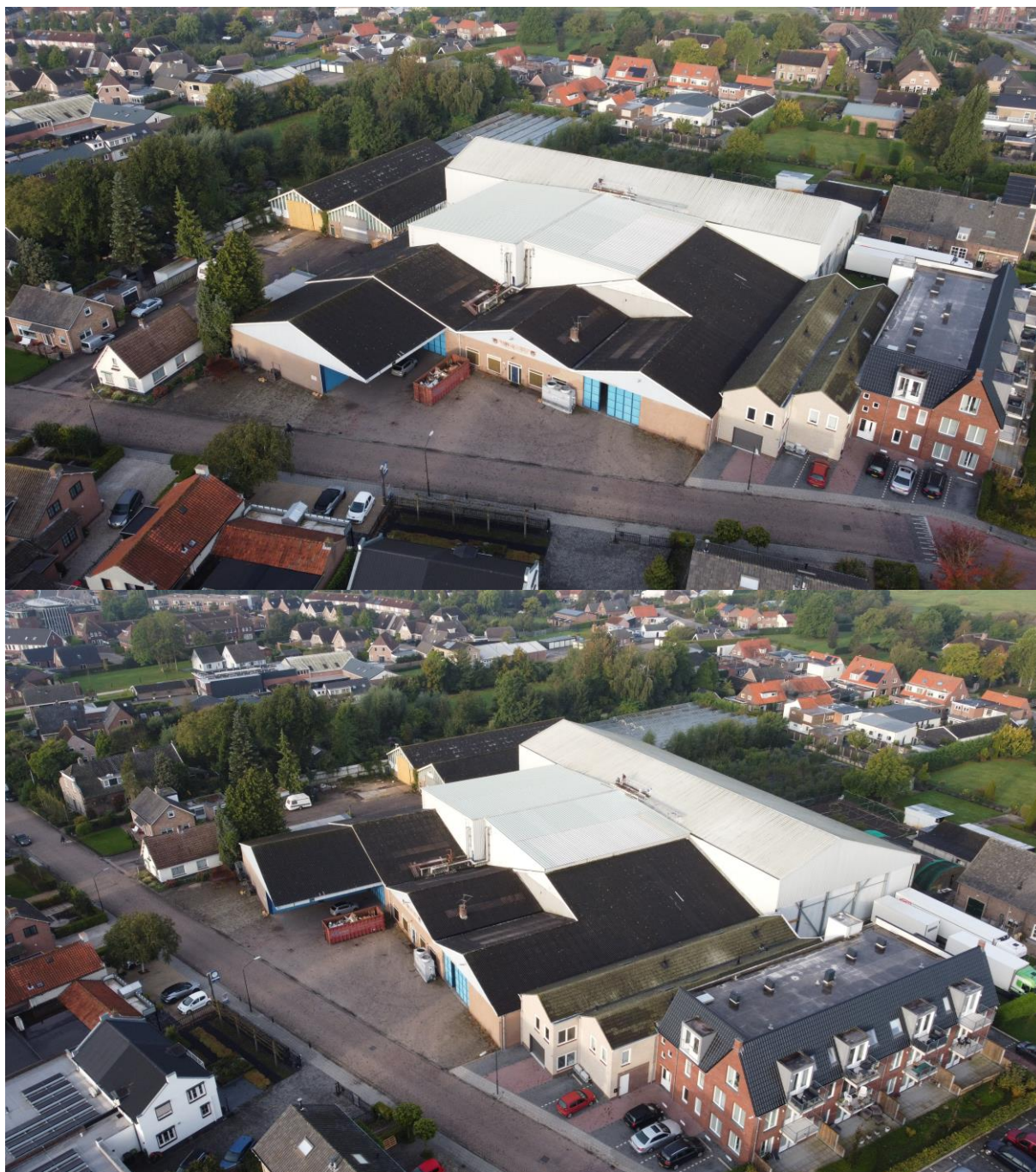
Afbeelding 6: Foto's bestaande situatie
