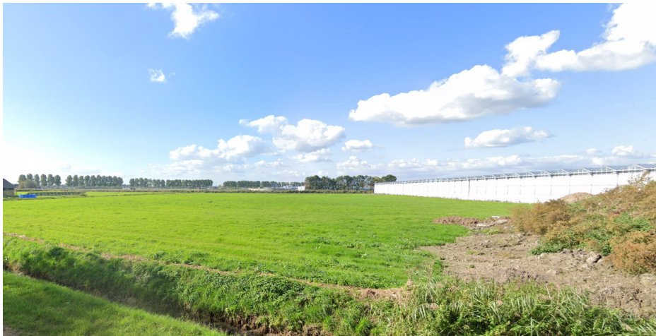
Aanzicht plangebied vanuit het oosten. Achter op de foto is de waterzuivering en zijn de boeren-bedrijven zichtbaar die achter het glastuinbouwgebied liggen. Het uitbreidingsgebied betreft dit grasland.
