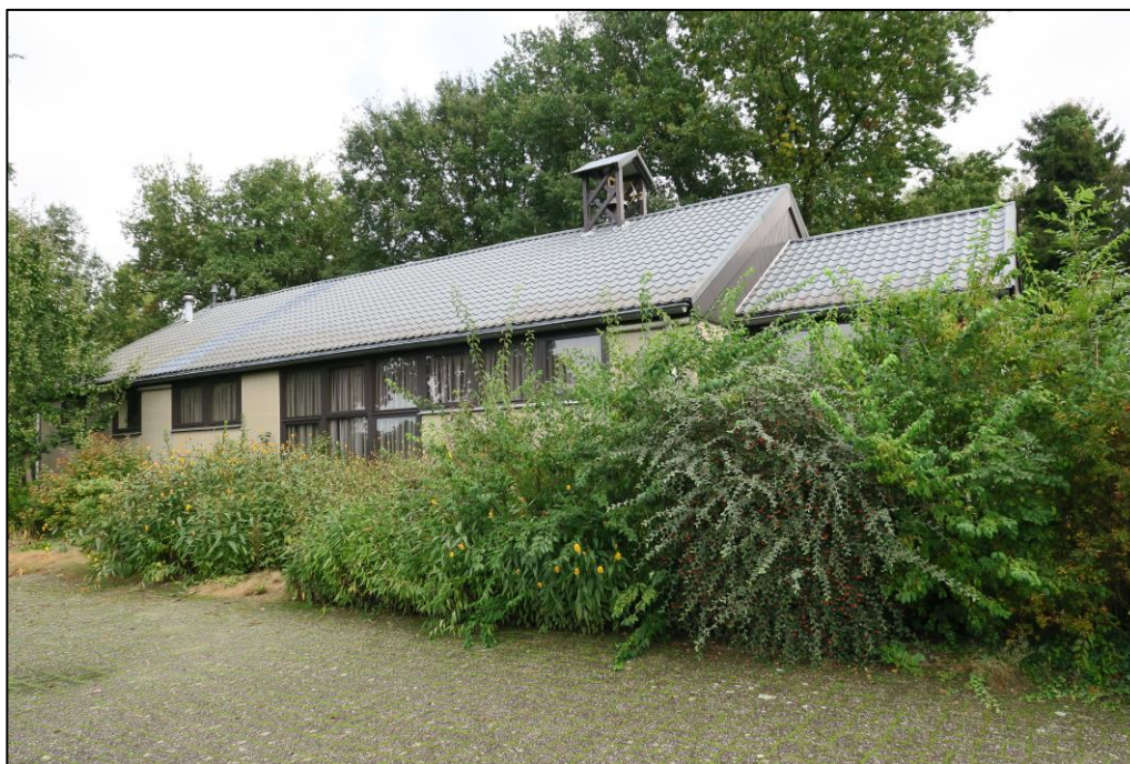
Figuur 1 De planlocatie is gelegen aan de Transvaal 65 te Sleeuwijk en bestaat uit een kerkgebouw.
