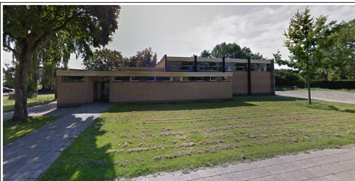
Figuur 6 – De voorheen aanwezige, maar reeds gesloopte, gymzaal/ sporthal in het plangebied (bron: Google Streetview)
