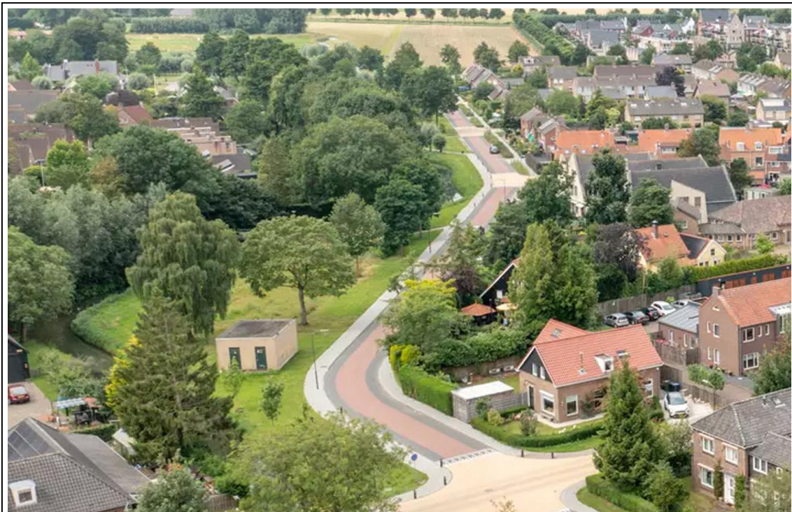
Figuur 8 – Luchtfoto (vogelvlucht) ter hoogte van de Vlietstraat, met aan de linkerkzijde het plangebied met het bestaande transformatorhuisje
