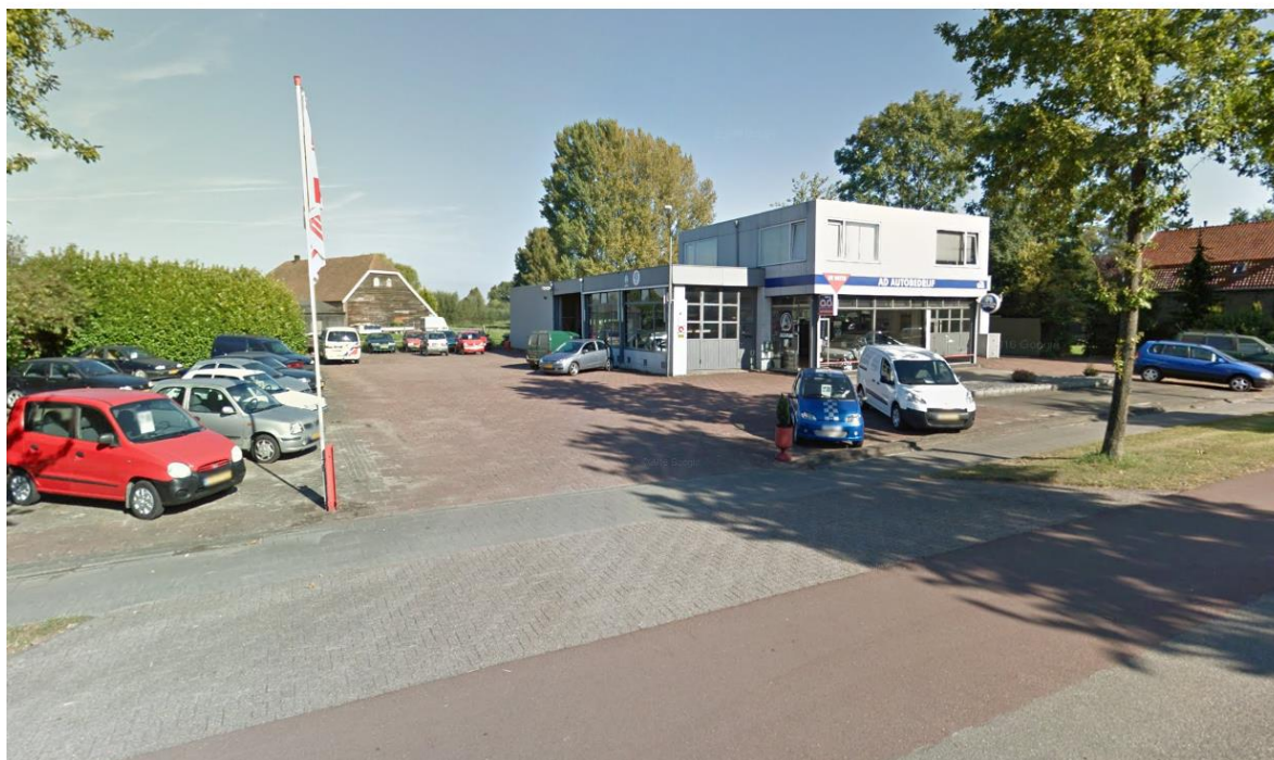
Figuur 2.6: Bestaande situatie, vrijwel geheel verhard terrein met een afwijkend bouwvolume
