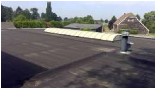
Dakbedekking niet verdacht
