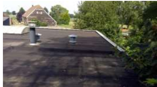
Dakbedekking niet verdacht
