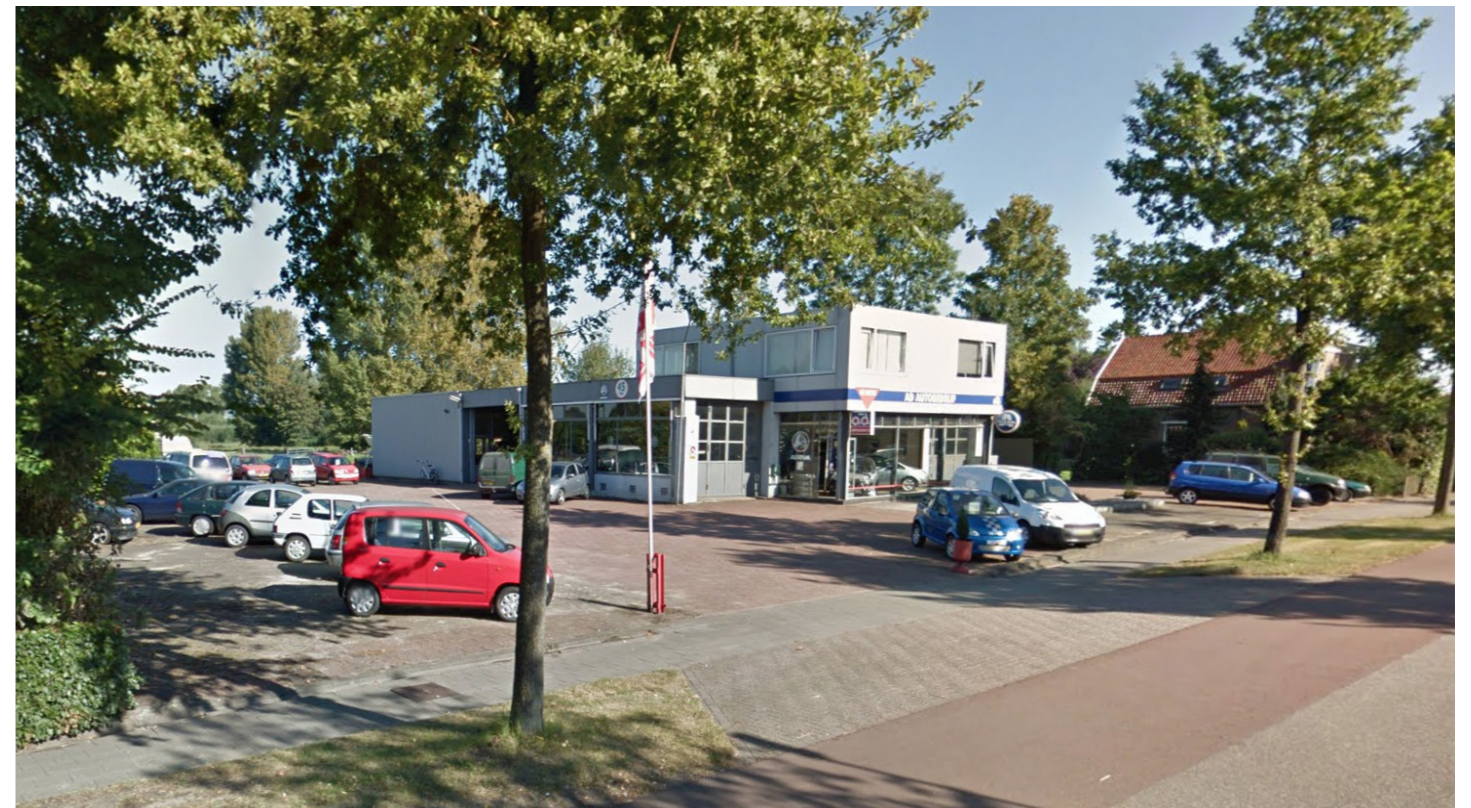
Bestaand aanzicht gezien vanaf de Rijksstraatweg
