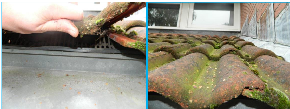
Foto's: Vogelwering en dakpannen strak op elkaar.
