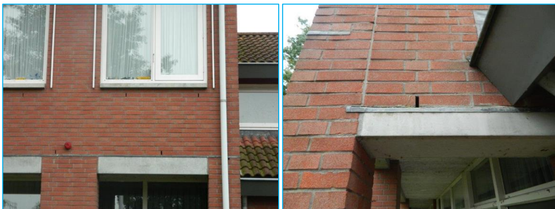
Foto's: Open stootvoegen zorgwoning.
