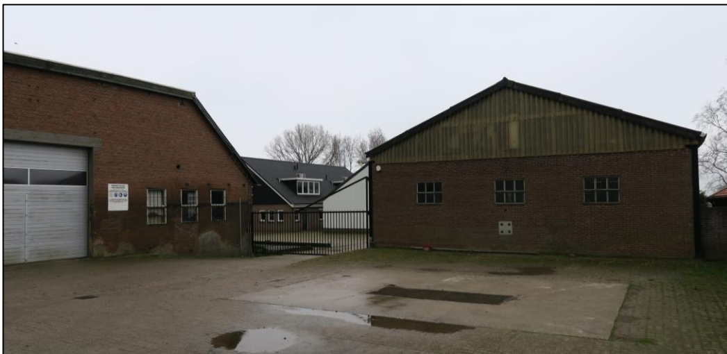
Figuur 1.2 Impressie van de planlocatie, het betreft vijf schuren, hier schuur B en C.
