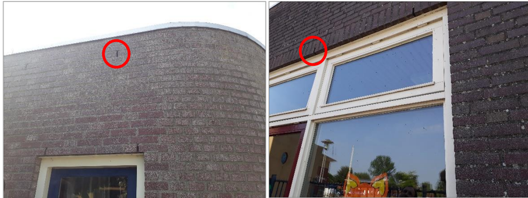
Figuur 4.5. Foto links: Paarverblijfplaats gewone dwergvleermuis. Foto rechts: Paarverblijfplaats ruige dwergvleermuis.
