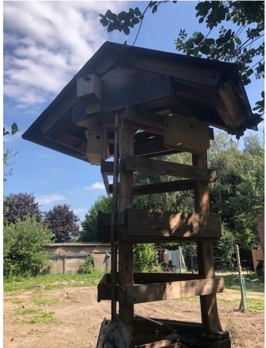
Figuur 12. Op de faunatoren zijn twee mussenflats aanwezig met in elke kast 3 nestlocaties. Er waren al indicaties van broedpogingen (onafgemaakt nest in de toren zelf en niet in de huismuskasten). Daarnaast zijn hier 2 vleermuiskasten opgehangen.
