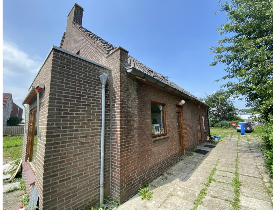
Figuur 5. Beeld van rechterzijgevel (oost).
