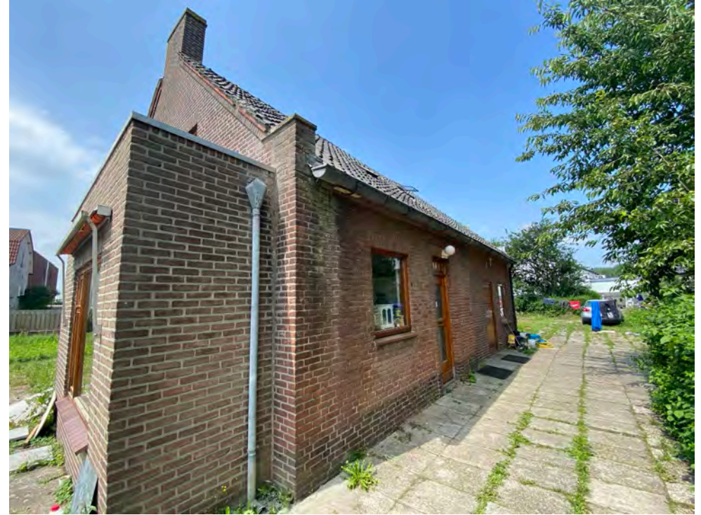
Figuur 5. Beeld van rechterzijgevel (oost).
