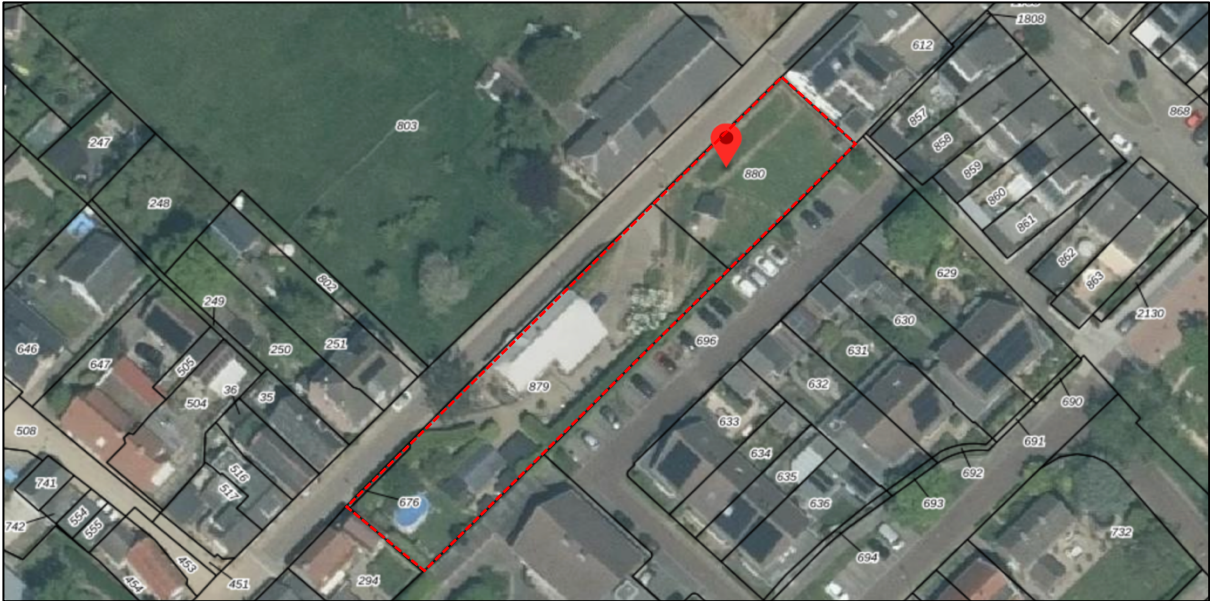
Plangebied Buitendijk 112 Hank Luchtfoto
