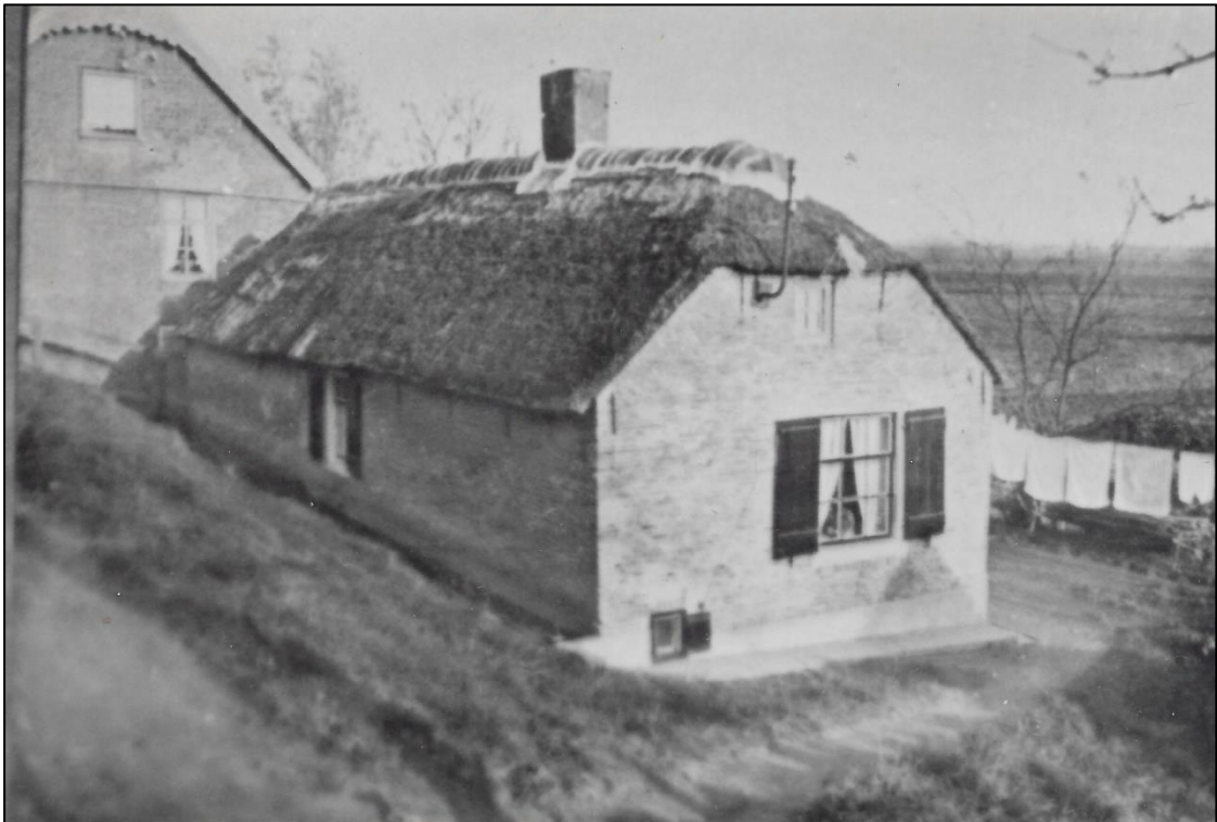
Figuur 12. Foto van de voormalige bebouwing in het plangebied (bron: opdrachtgever).
