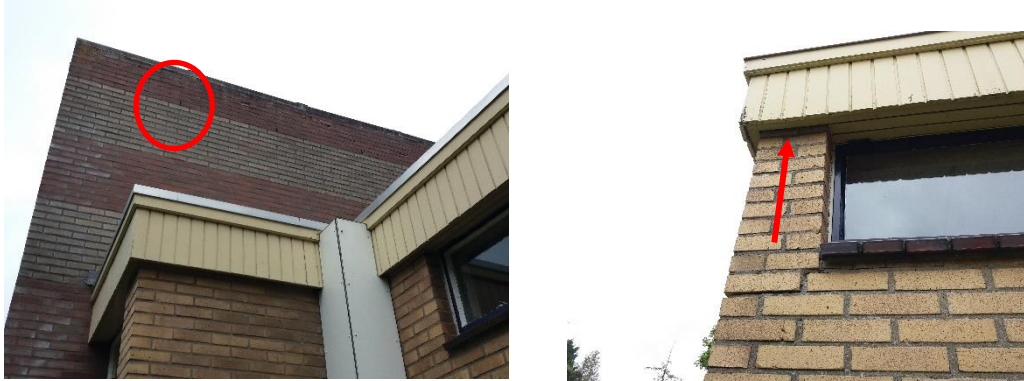
Figuur 3-3 a en b. voorbeelden van mogelijke plekken voor vleermuizen om te verblijven in de gymzaal te Sleeuwijk
