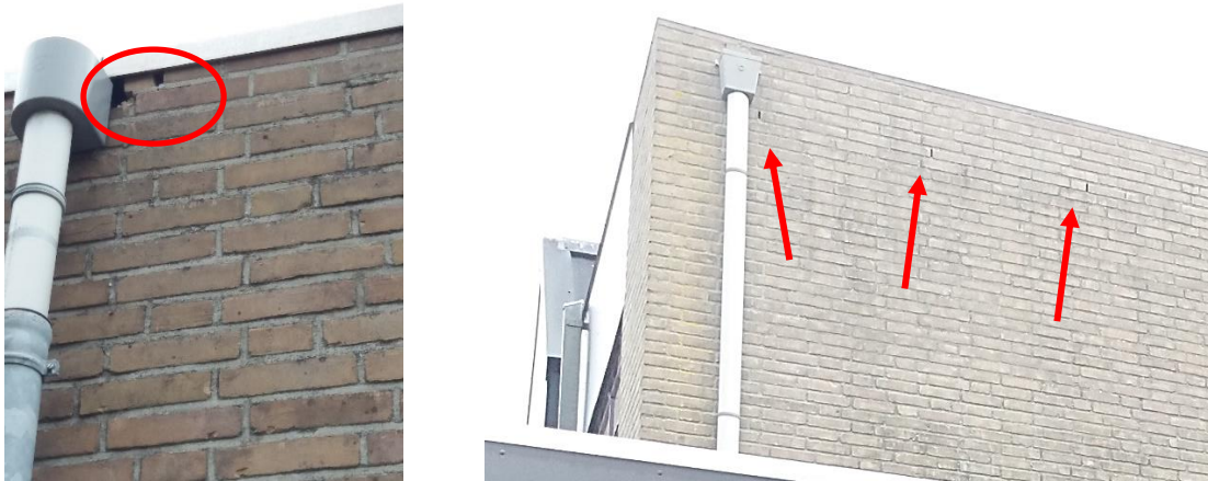
Figuur 3-4 a en b. Voorbeelden van mogelijke plekken voor vleermuizen om te verblijven in sporthal 'de Fuik'
