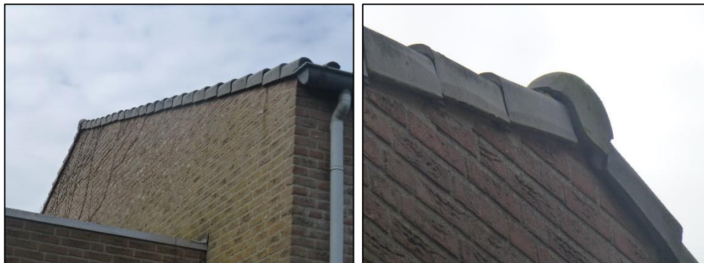
Figuur 4.3. Impressie mogelijke locaties voor verblijfplaatsen van vleermuizen. Vleermuizen kunnen achter de nok en kantpannen kruipen waar ze (ook) toegang kunnen vinden tot de spouw.
