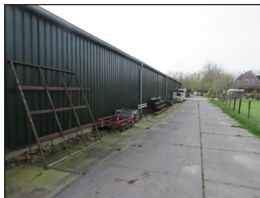
Foto 2. Betonplaten ten westen van de loods vanaf het noorden
