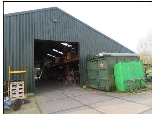
Foto 6. Betonplaten ten noorden van de loods met rommel
