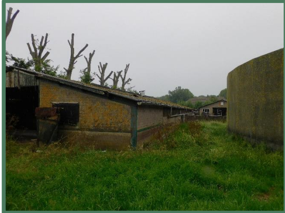
Achtergevel kalverenstal met mestsilo
