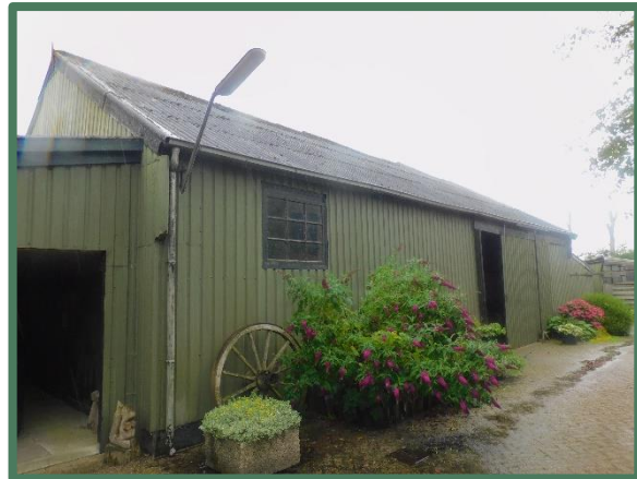
Loods met asbesthoudend dak
