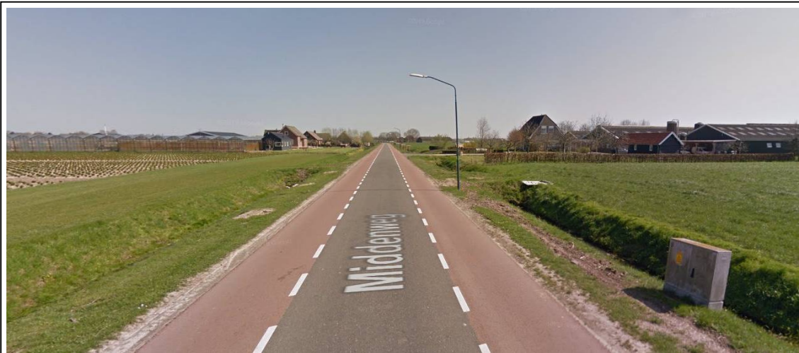
Figuur 9 – Bestaande situatie Middenweg (bron: Google Streetview)
