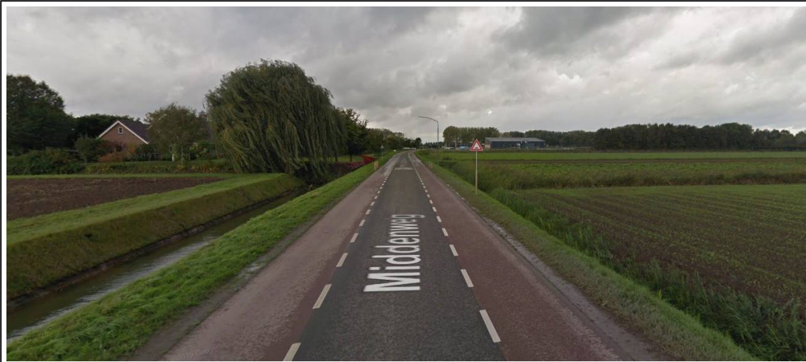
Figuur 8 – Bestaande situatie Middenweg (bron: Google Streetview)
