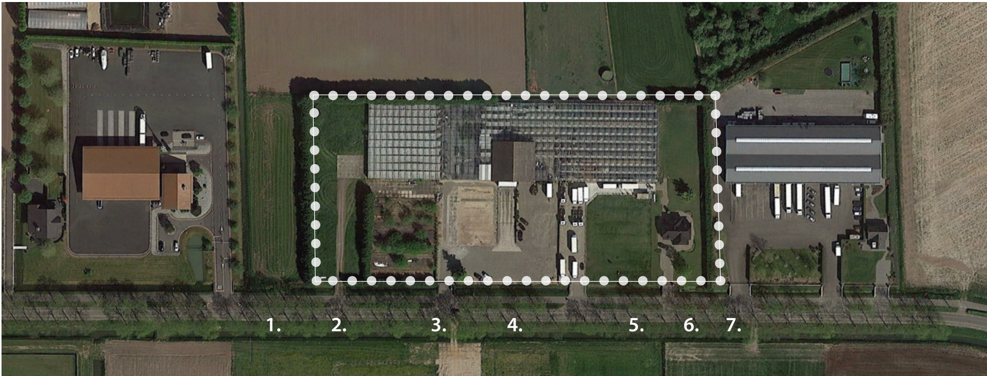
Luchtfoto en posities StreetView afbeeldingen
