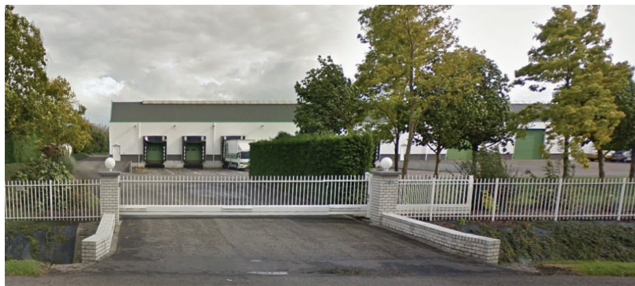
Groeneweg - bebouwd perceel aan zuidoostzijde
