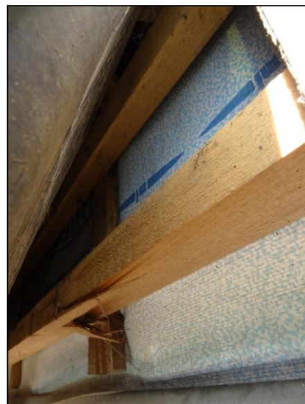
Figuur 9. Houten latjes achter de dakpannen.
