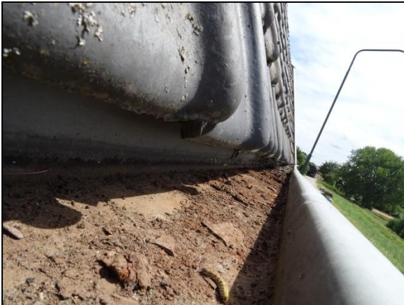
Figuur 10. Ruimtes onder de dakpannen.
