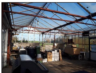
Figuur 6. Gedeelte van de kassen in gebruik voor opslag.
