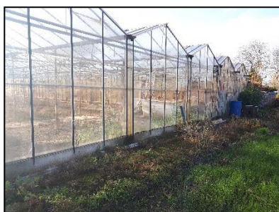
Figuur 4. Te slopen kassen.
