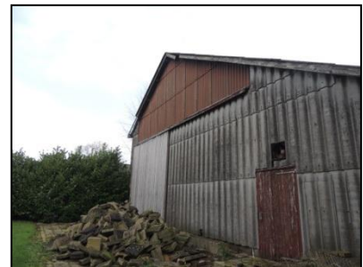
Figuur 5. Westzijde van de schuur.
