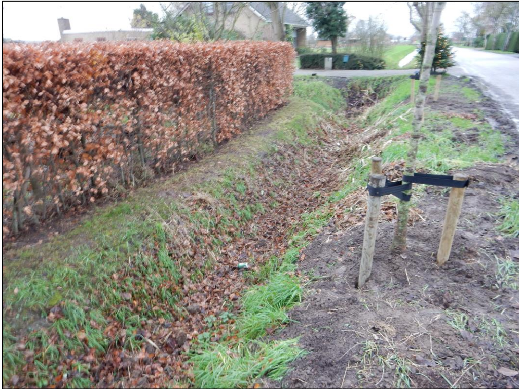
Figuur 3 De drooggevallen sloot behorend tot de planlocatie. In deze sloot zal de duiker geplaatst worden ten behoeve van de inrit. Ook zal hier een deel van de beukenhaag verwijderd worden.
