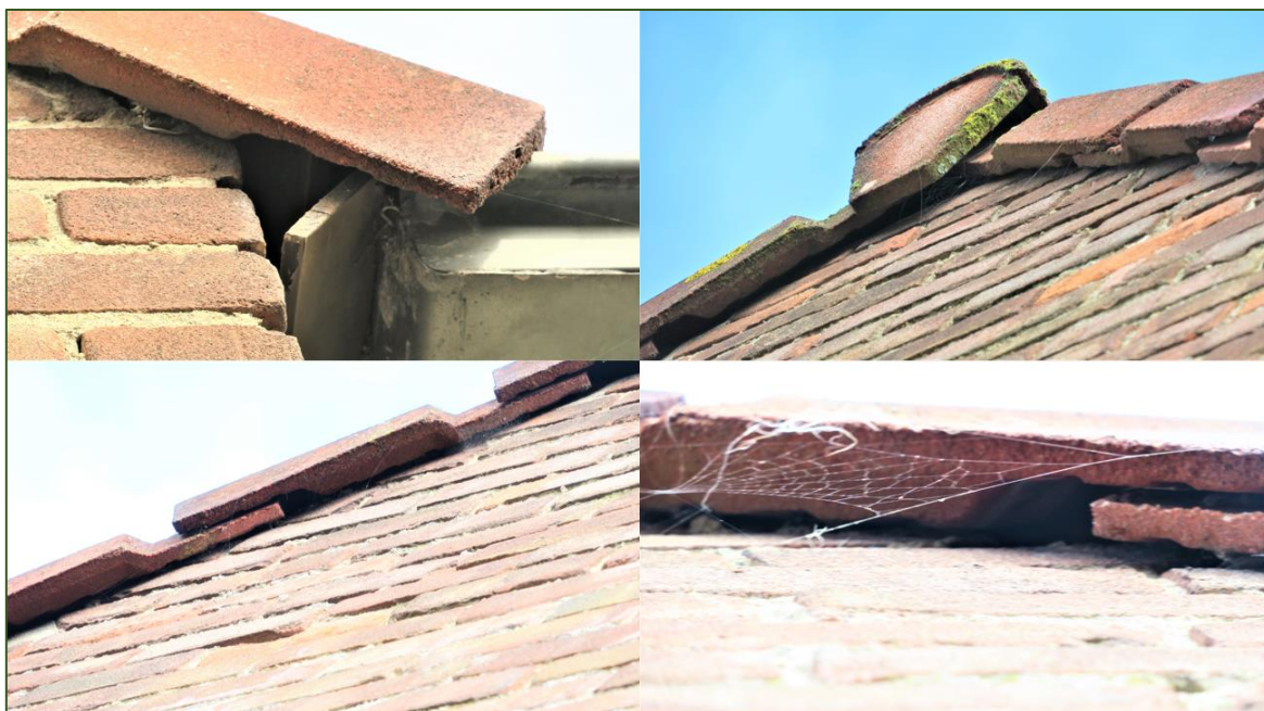
Figuur 3.4 Links boven met de klok meer naar rechts: onderste rij dakpannen is afgeschermd met een houten lat, maar is via de zijkanten toegankelijk voor huismussen, geschikte invliegopeningen onder de eindvorsten en kantpannen, waar gierzwaluwen, huismussen en vleermuizen toegang kunnen krijgen tot de dakruimte en/of de luchtpouw.
