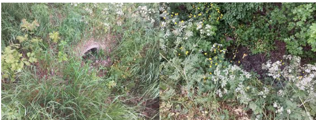
Figuur 1.1: Bestaande duiker ten noordoosten van de projectlocatie (Geofoxx, locatiebezoek op 10-5-2022)
