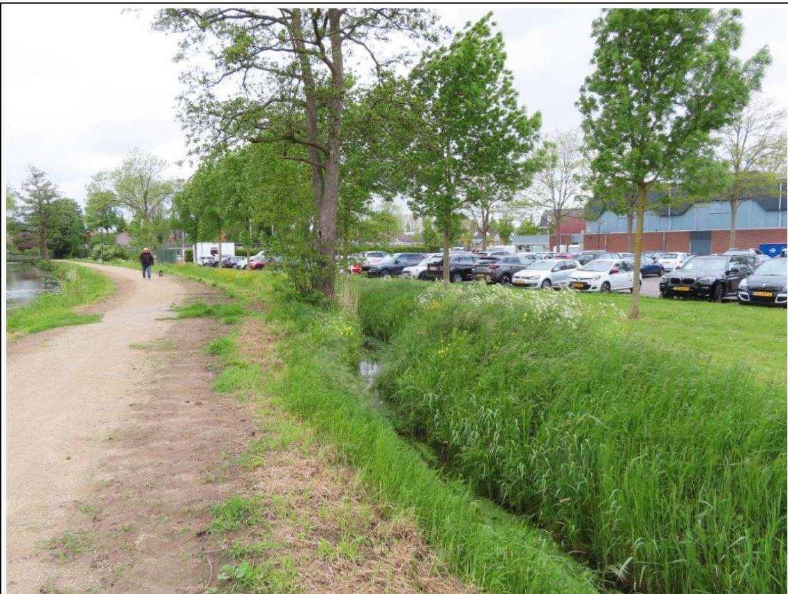
Figuur 11 – Huidige situatie groene zone ten zuiden van het plangebied, met van links naar rechts; de wetering de Alm, het halfverharde pad, de bermsloot en een groenstrook met een bomenrij (bron: EcoTierra)
