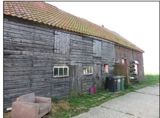
Foto 4: Te slopen gebouw
