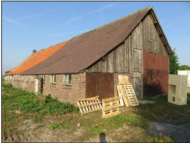
Foto 1: Te slopen gebouw
