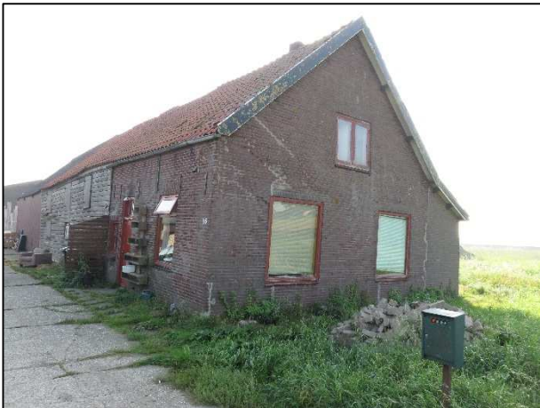
Foto 3: Te slopen gebouw
