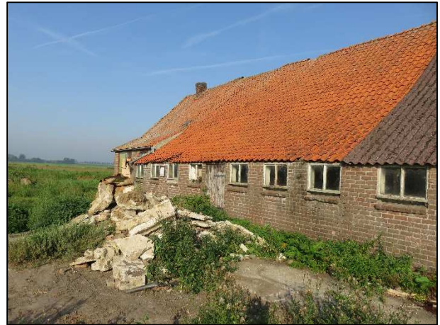
Foto 2: Te slopen gebouw
