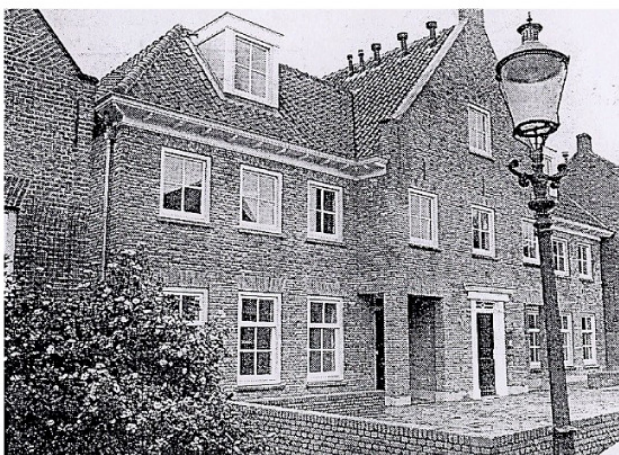
verschillen in dakhelling langskap/ dwarskap
