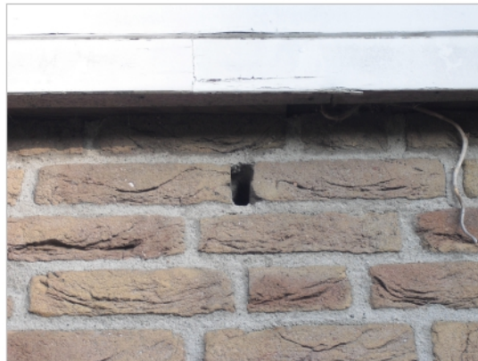
Impressie van het plangebied ten tijde van het veldbezoek (foto's: MIECON 18 januari 2017). Boven: gedeeltelijk verruigde tuin. Linksonder: eenlaags woning. Rechtsonder: gemetselde muren met open stootvoegen.
