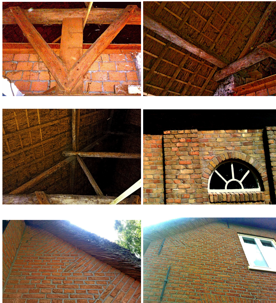
Figuur 8 Details binnenzijde (spanten en constructie) en buitenzijde (gevelelementen en rieten dakbedekking) boerderij Oudendijk 92 (Struik & Partners 2014).
