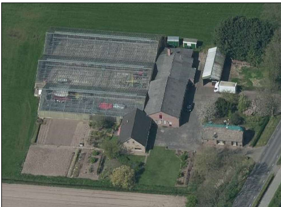
Figuur 5 : Luchtfoto situatie 2016
