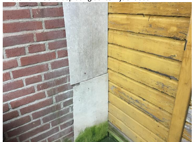
Foto 20: Gevelbeplating achterzijde loods
