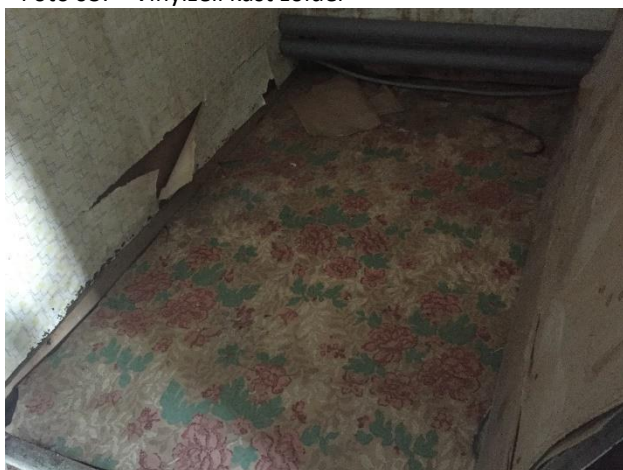
Foto 03: Vinylzeil kast zolder
