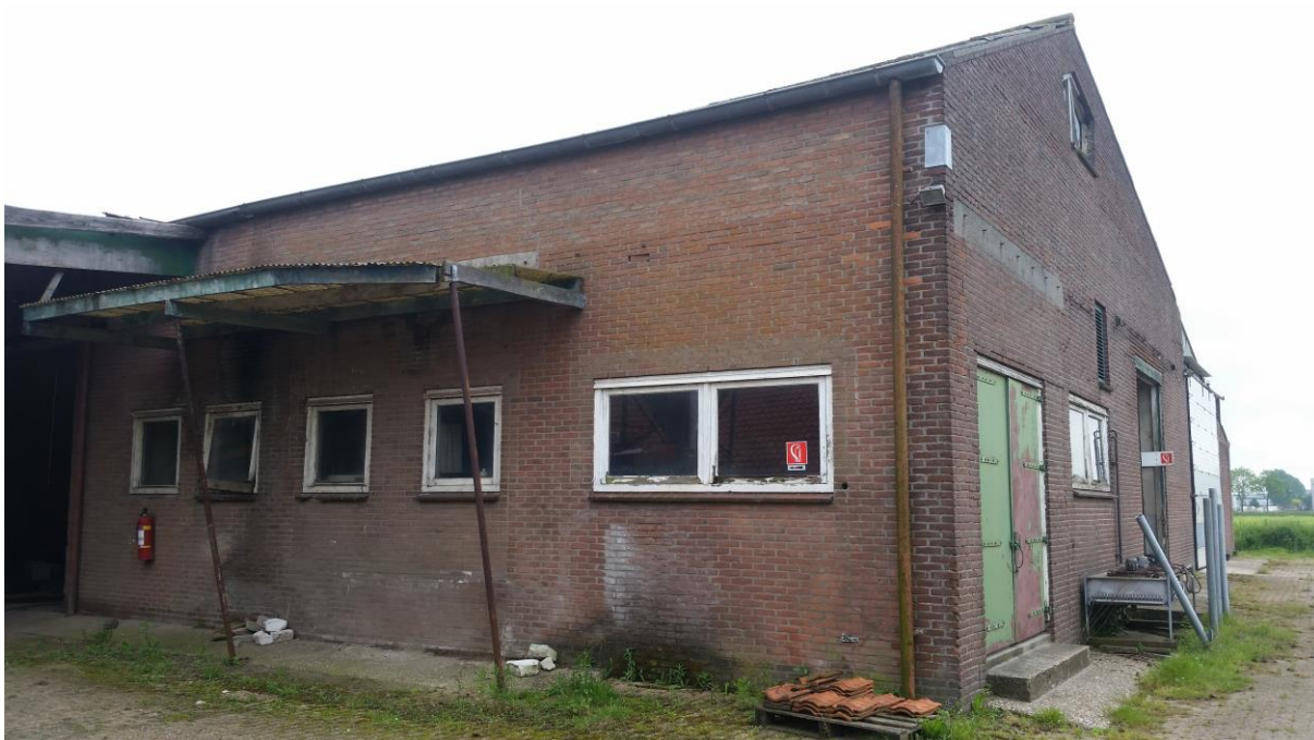
Foto 4. Gebouw 4, hoge deel met golfplaten dak
