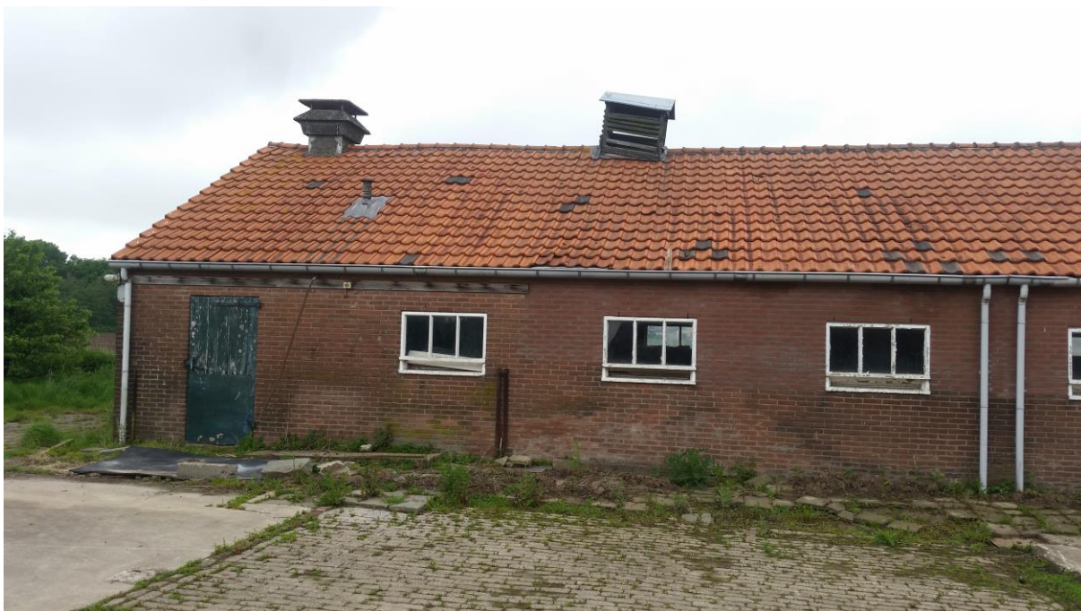
Foto 3. Gebouw 3, lage deel met dakpannen dak
