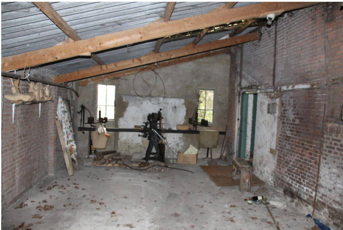
14. Later aangebouwde garage, sporen van afgebroken bebouwing zijn zichtbaar (wit gekalkt)
