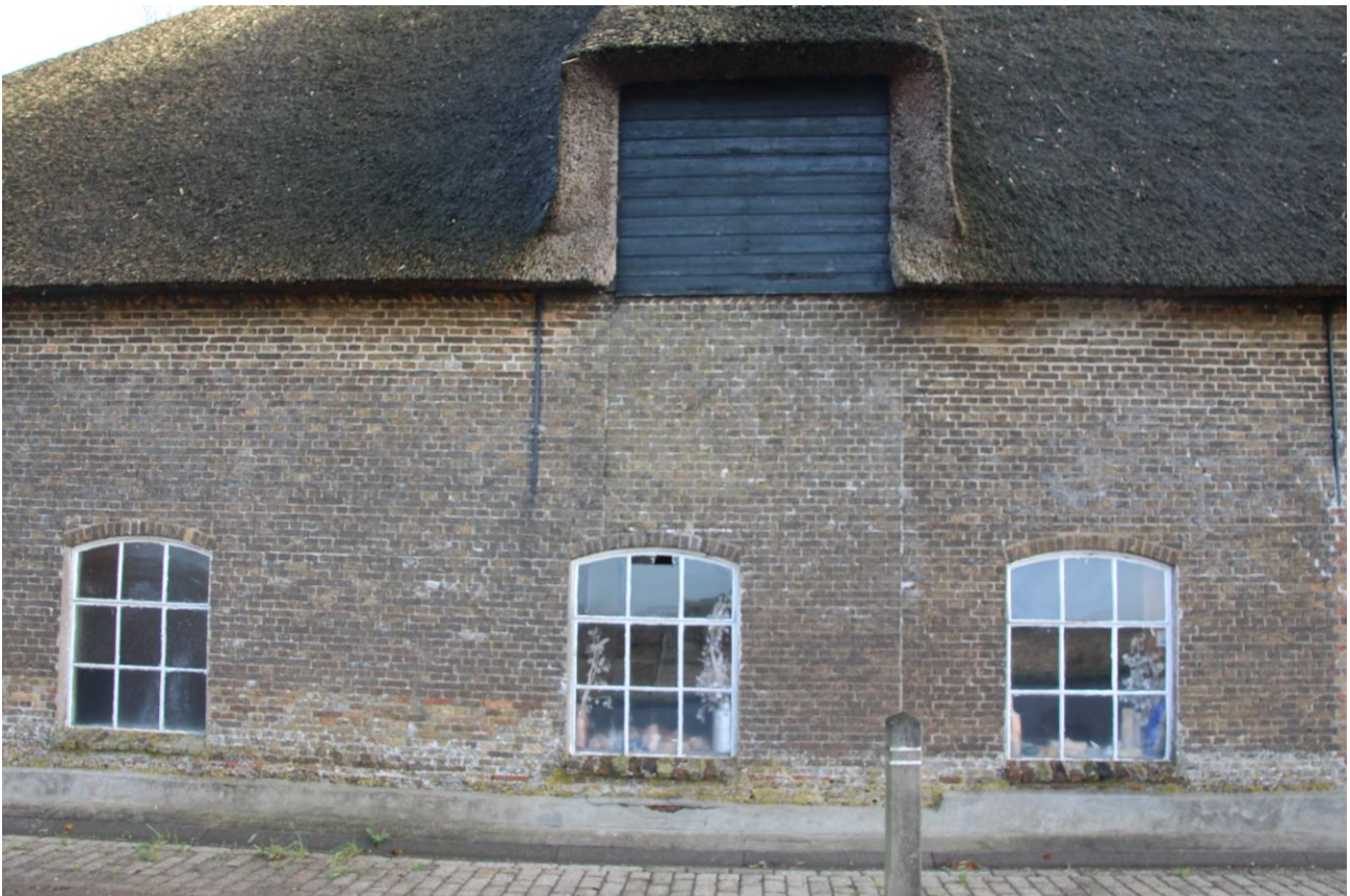
6. Ter plaatse van het huidige hooiluik heeft waarschijnlijk een poort gezeten, gezien de bouwnaden aan de beide zijden parallel aan het hooiluik.
