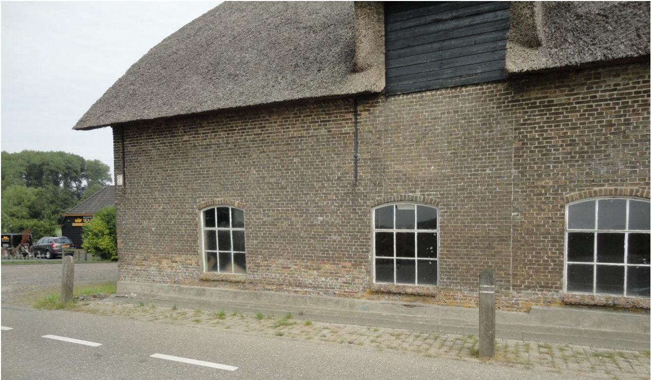
8. De stalen ramen in de westgevel zijn waarschijnlijk uit de periode dat de boerderij in gebruik was als looierij, tussen 1885 - 1913
