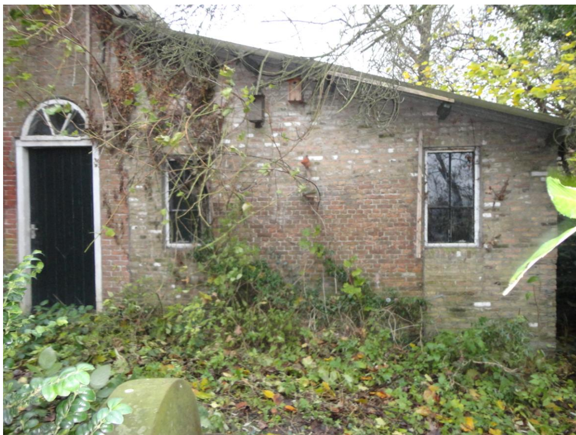
2. aanbouw aan de oostzijde van de boerderij
