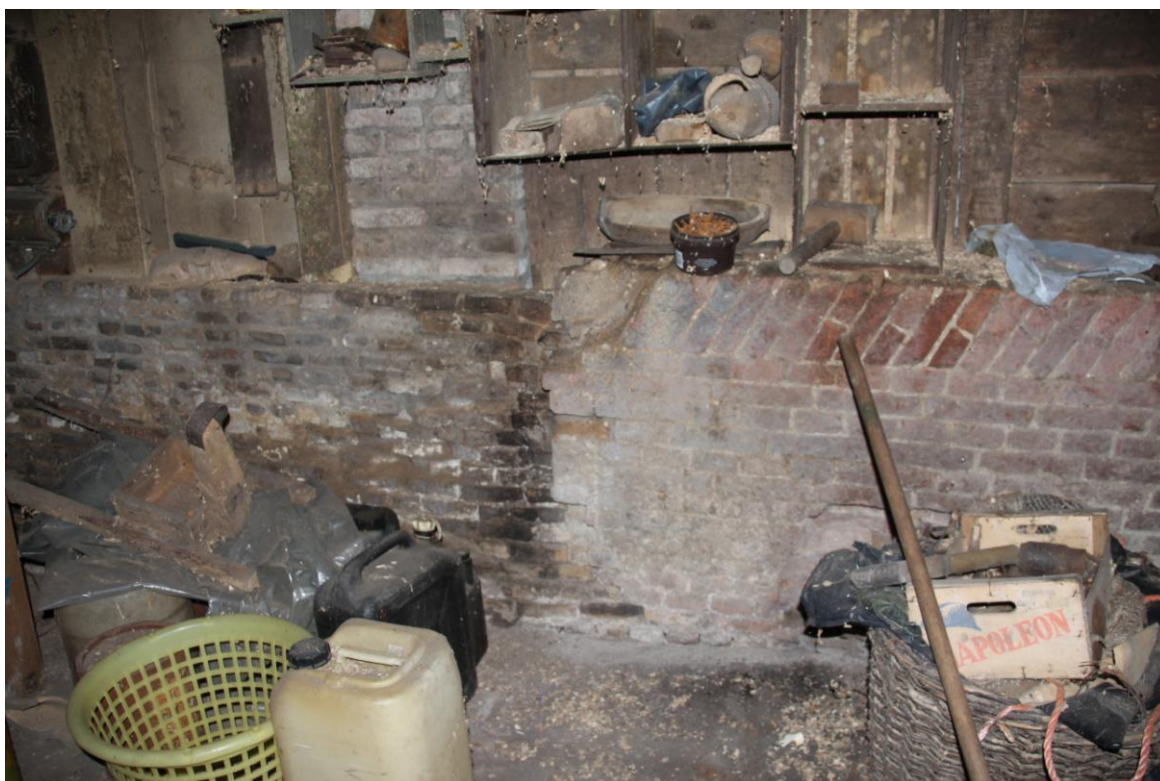
13. Detail schuur; metselwerk ter plaatse van lager gelegen deel.
