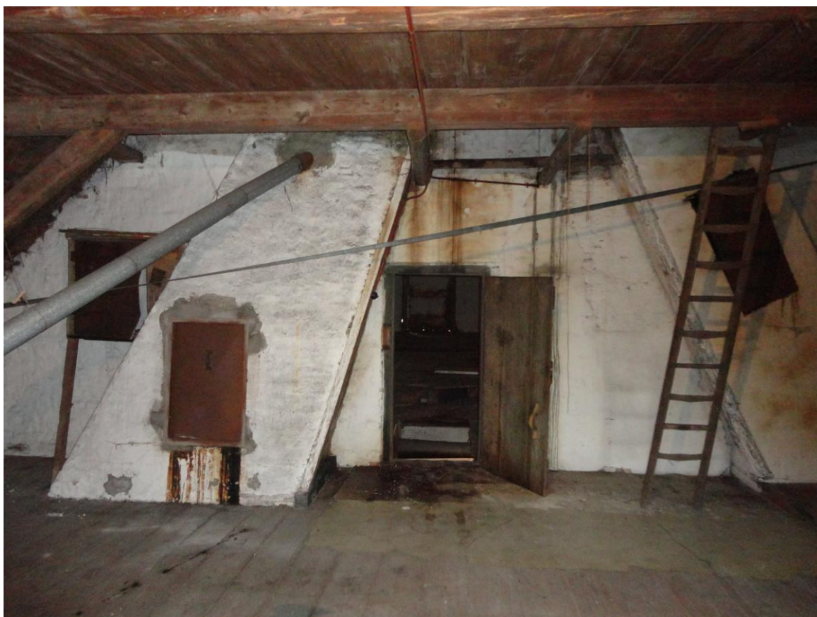
9. Eerste verdieping boven het woongedeelte, gezien richting brandmuur tussen woongedeelte en schuur. Tevens zichtbaar de twee oude schoorstenen en de later aangebrachte schoorsteen (foto nr. 4) Deze brandmuur verjongd aan de bovenzijde, aan de bovenzijde bevinden zich vlechtingen.
