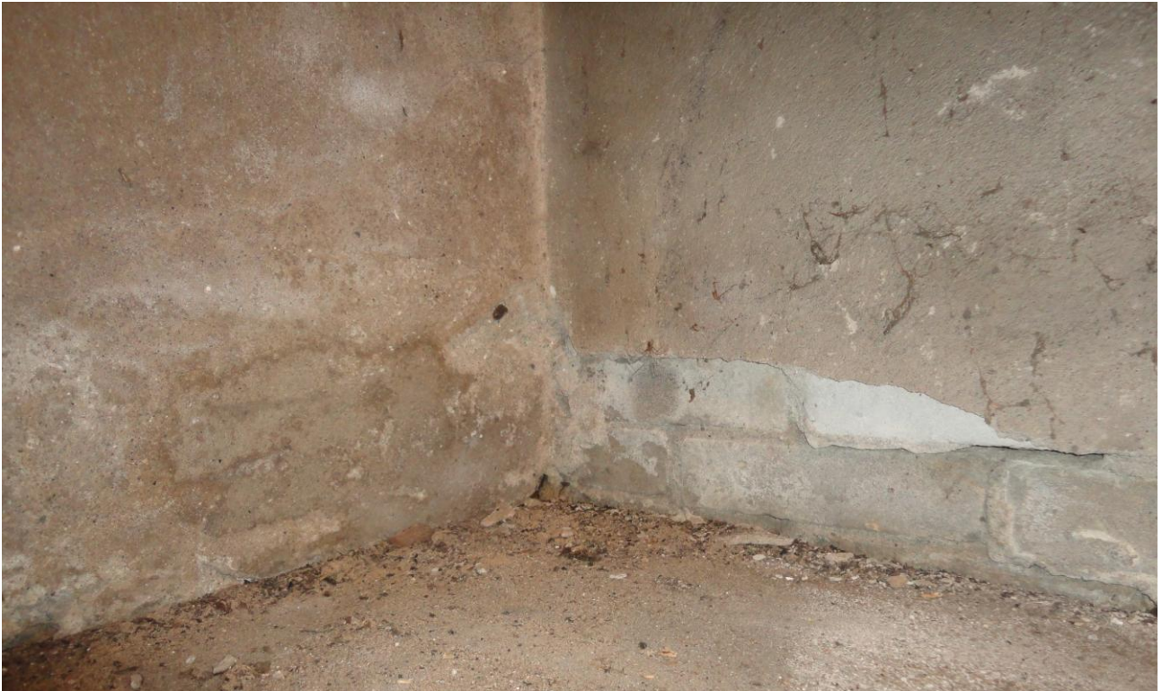
16. Een aantal wanden in het schuurdeel zijn een latere toevoeging. (kalkzandsteen). Erfgenamen hebben eveneens bevestigd dat deze er niet altijd gestaan hebben.
