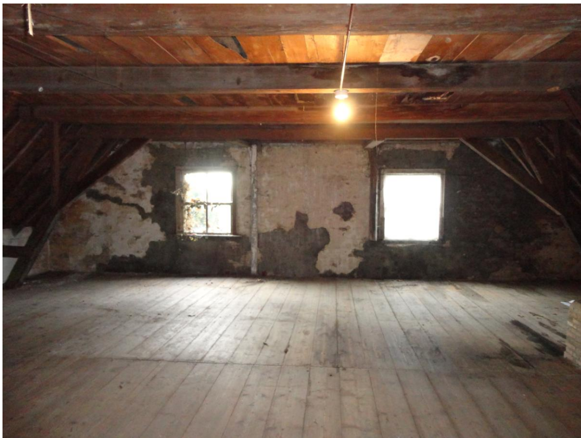
8. Eerste verdieping boven het woongedeelte. Houten vloerdelen met messing en groef.
