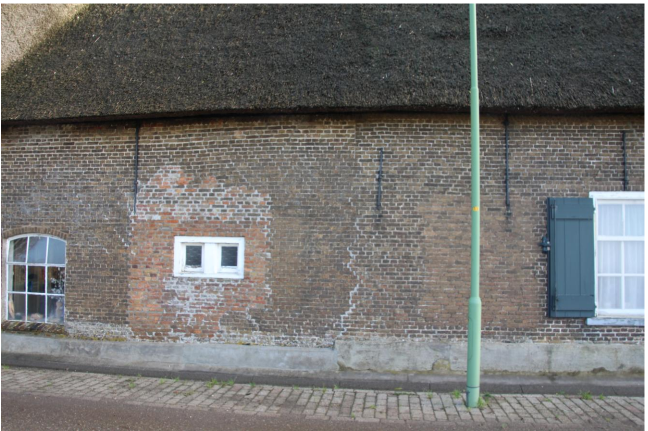
9. Ter hoogte van de brandmuur is een vertanding (bouwnaad) en een sprong in de plint zichtbaar. Het is niet ondenkbaar dat het schuurdeel van de boerderij oorspronkelijk uitgevoerd is in hout en later gefaseerd is vervangen in steen. Wanneer je naar boerderijen in de nabije omgeving kijkt zie je dat bijna alle schuurdelen uitgevoerd zijn in hout.
