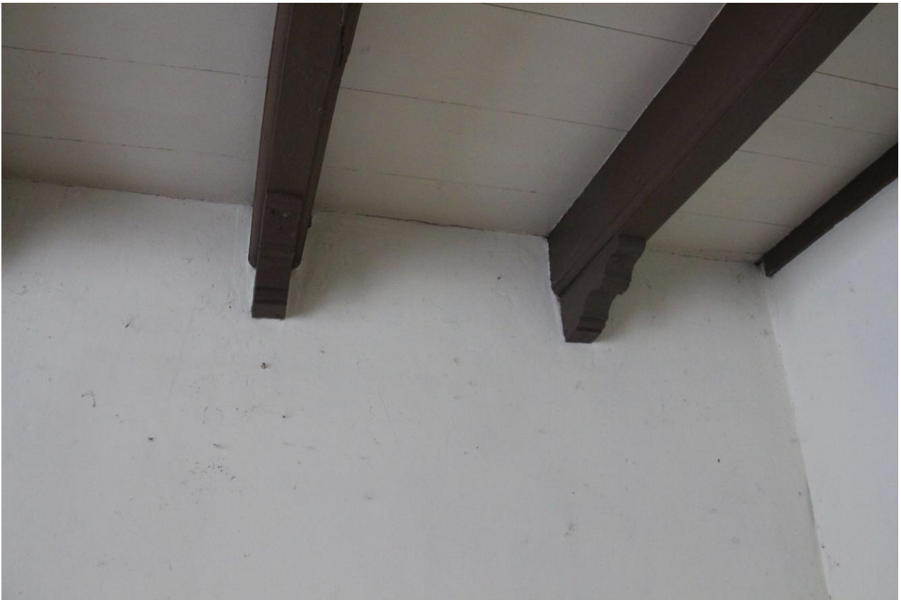
21. In de linker woonkamer bevinden zich aan de buitengevelzijde sleutelstukken onder de balklaag.
