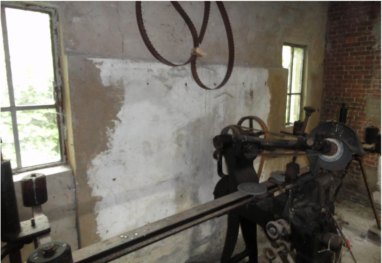
13. Aan de binnenzijde van de aanbouw is ter plaatse van het originele metselwerk een verdikking aanwezig.
