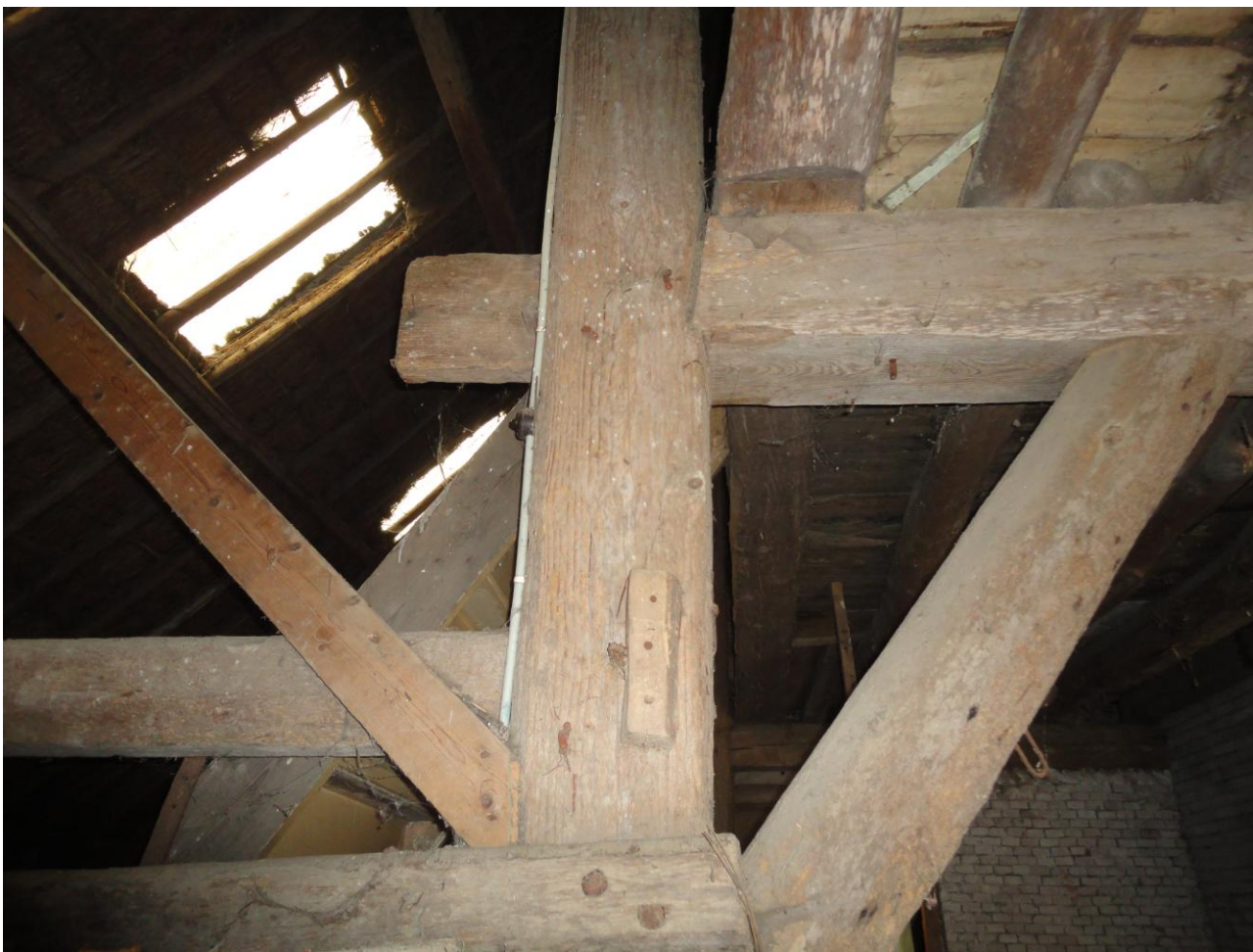
15. De ankerbalkconstructie in het schuurdeel is voor een groot deel origineel slechts, op enkele plaatsen zijn reparaties uitgevoerd of delen vervangen.
