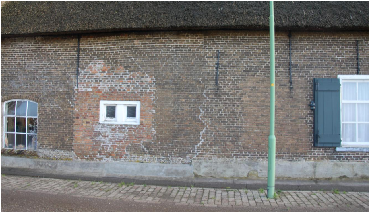
5. In de westgevel heeft in het verleden ter plaatse van de huidige badkamer een deur gezeten, dit is eveneens terug te zien op familie foto's.
