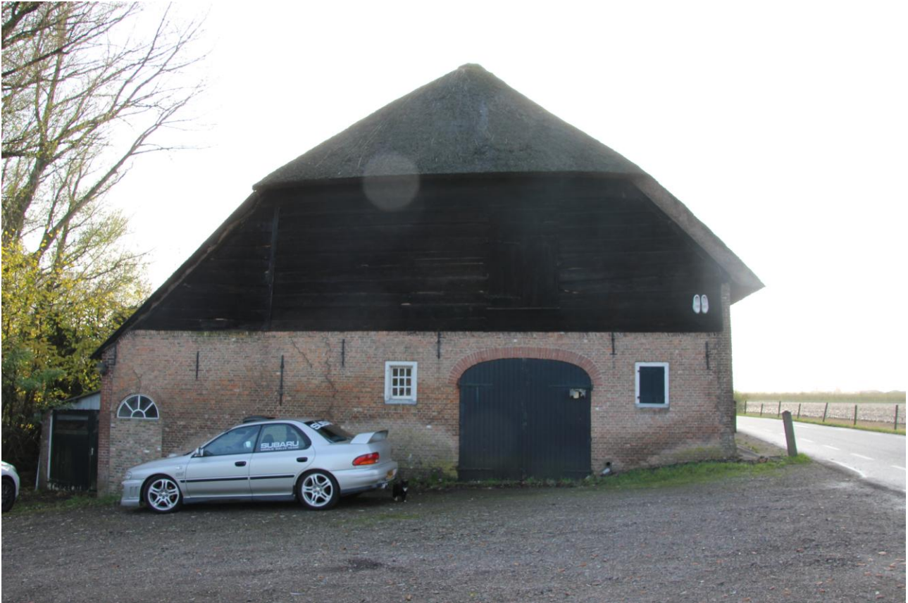
10. In de achtergevel zijn eveneens vertandingen/bouwnaden zichtbaar wat erop duidt dat het schuurdeel in fasen is versteent.
