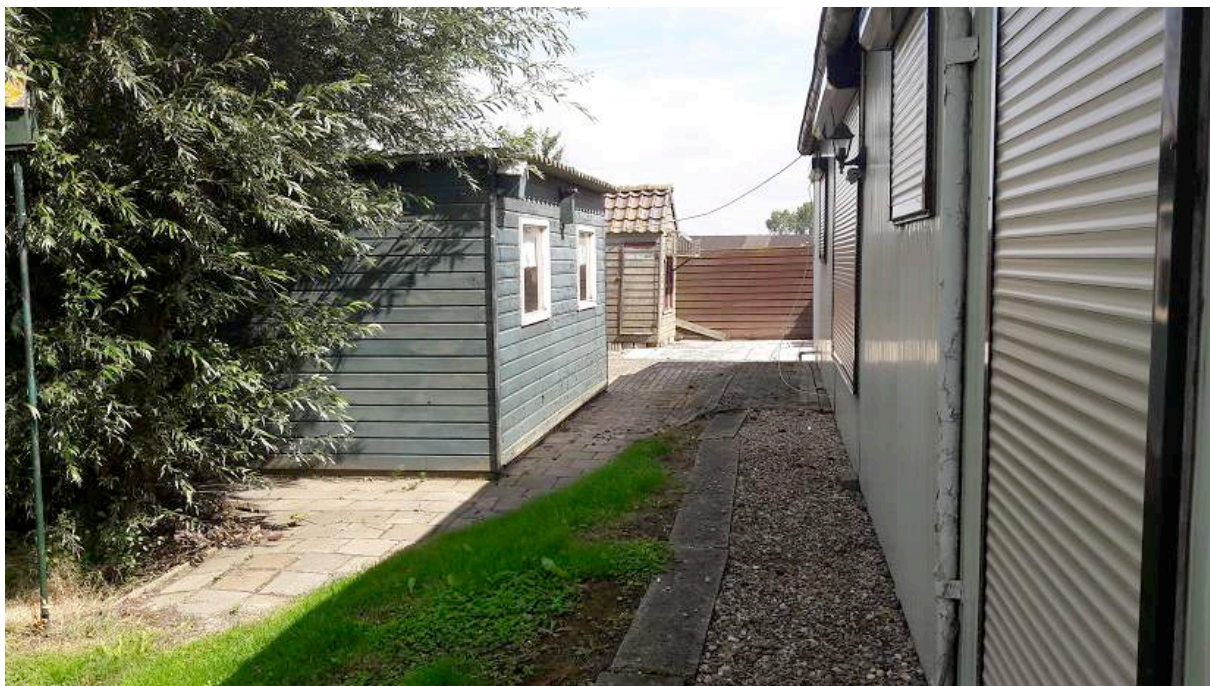
Schuur en duiventil aan de achterzijde van de woning.
