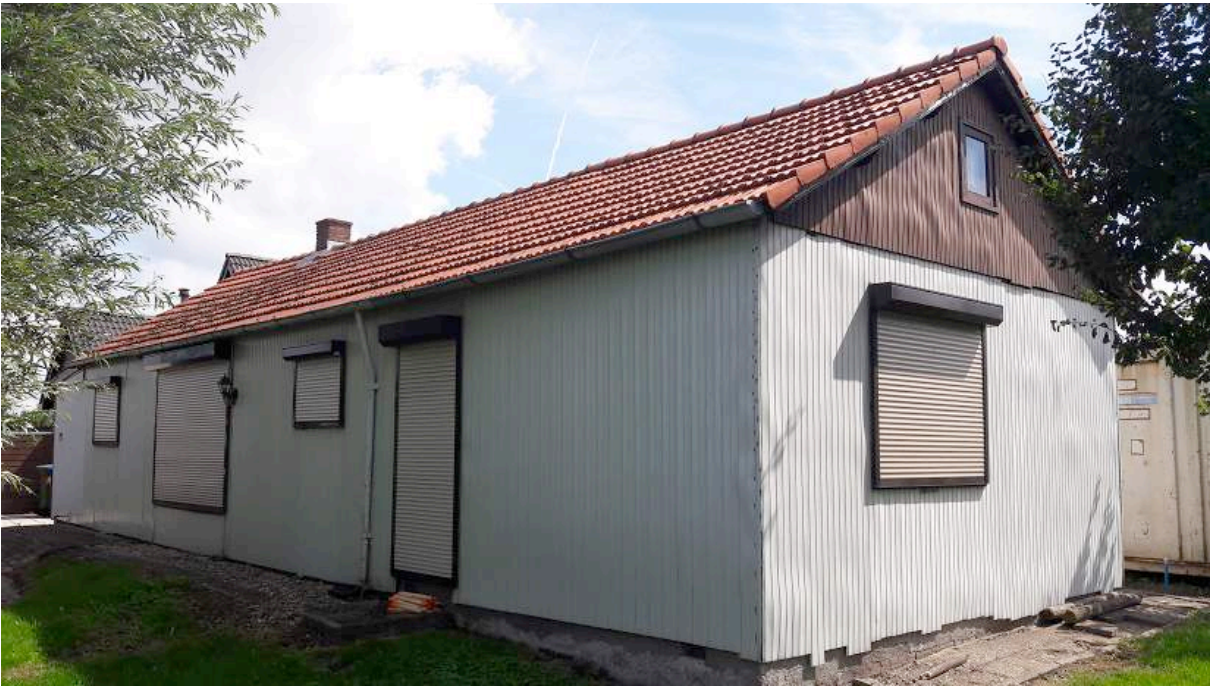
Afbeelding 2: Woning in het plangebied vanaf de achterzijde.
