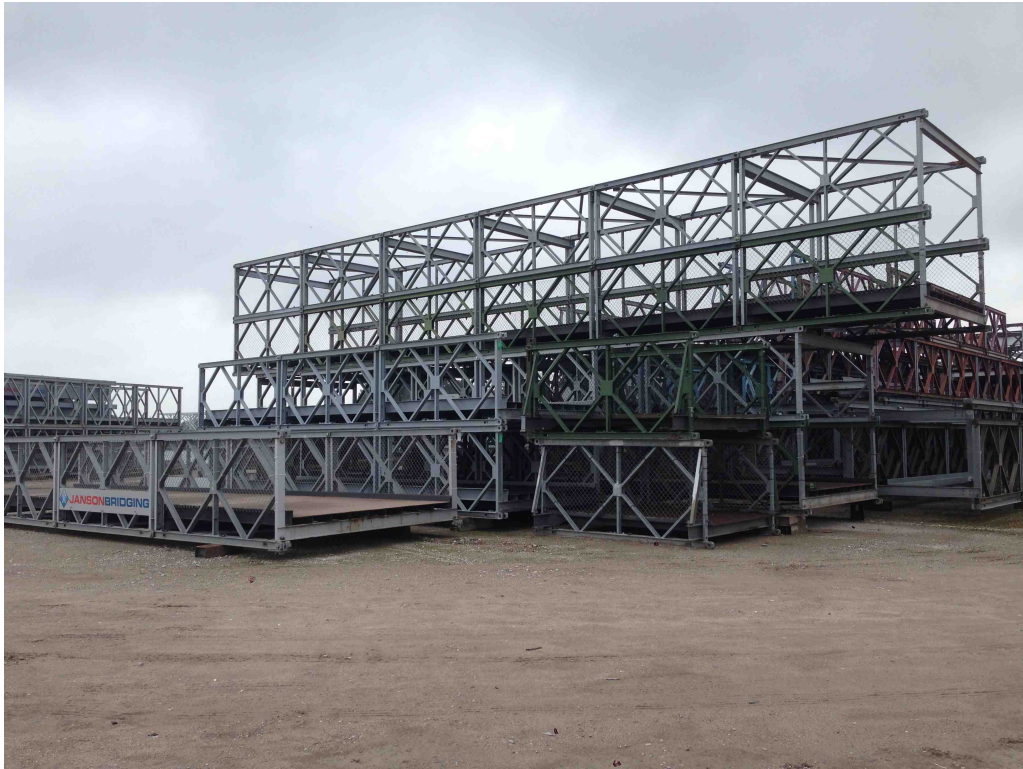
Figuur 1 De planlocatie is gelegen aan de Keizersveer 5-15 te Hank. Op de locatie is Janson Bridging gevestigd, er worden m.n. bruggen en brugdelen geconstrueerd en tijdelijk opgeslagen.
