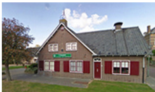
Afbeelding 5 - Het huidige gebouw van het Uivernest - in traditionalistische wederopbouwstijl.
