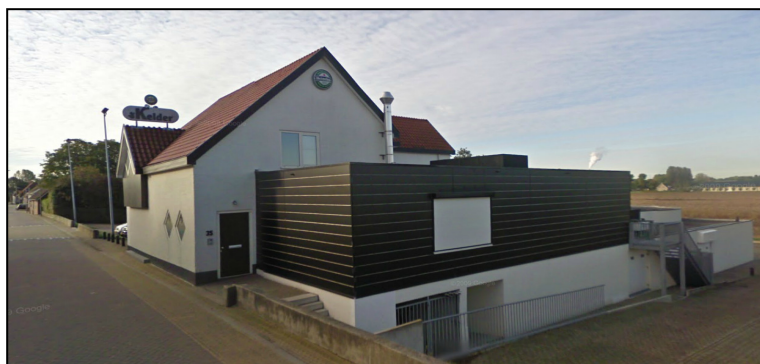
Figuur 2.2: Aanzicht De Kelder vanaf de Buitendijk 1
