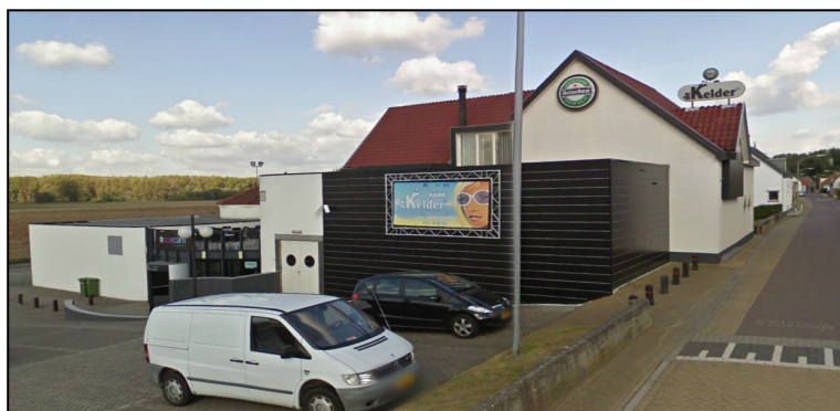
Figuur 2.3: Aanzicht De Kelder vanaf de Buitendijk 2
